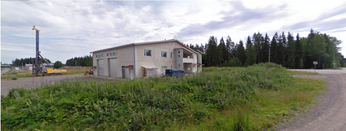
Kuva 2. Linnatien ja Mt140 risteyksessä oleva naapurikiinteistö.
