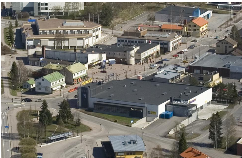
Kuva 10. Mäntsälän keskusta vuonna 2007. Marketti on rakennettu.
