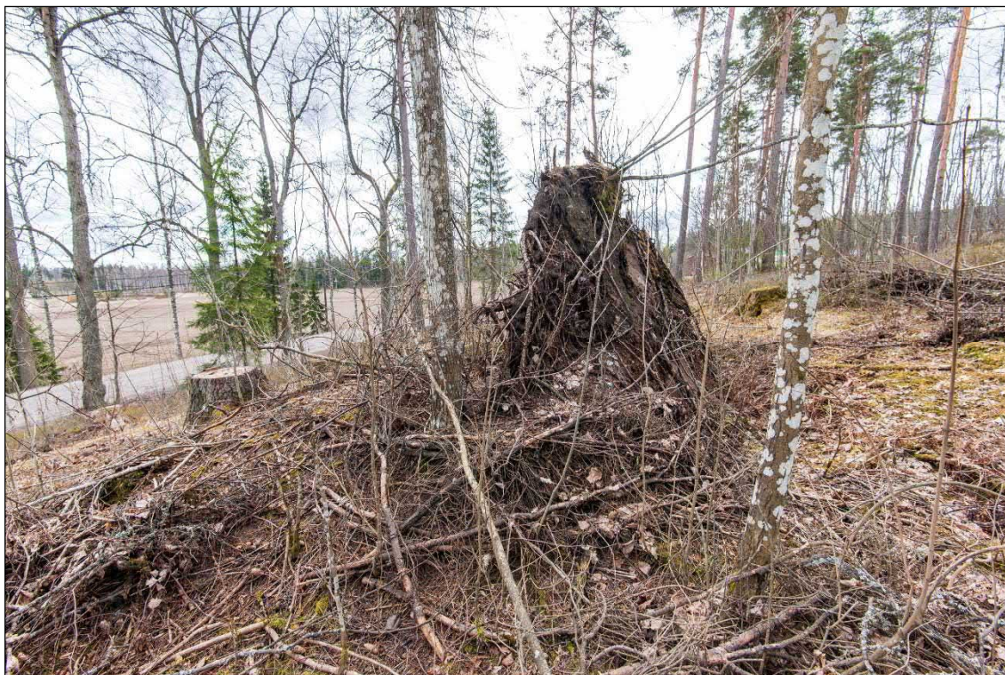
AKDG6269:1 Andersberg torppa. Torpan tai muun vastaavan rakennuksen kivijalka, jota tuulenkaato on pahoin vaurioittanut. Kuva lännestä.
