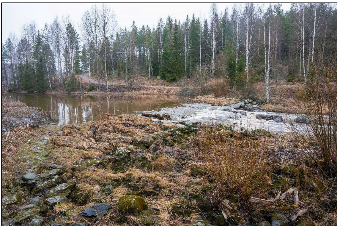
AKDG6208:3 Hurankoski. Myllynpaikka ja patorakenteita koskessa. Kuva etelästä.
