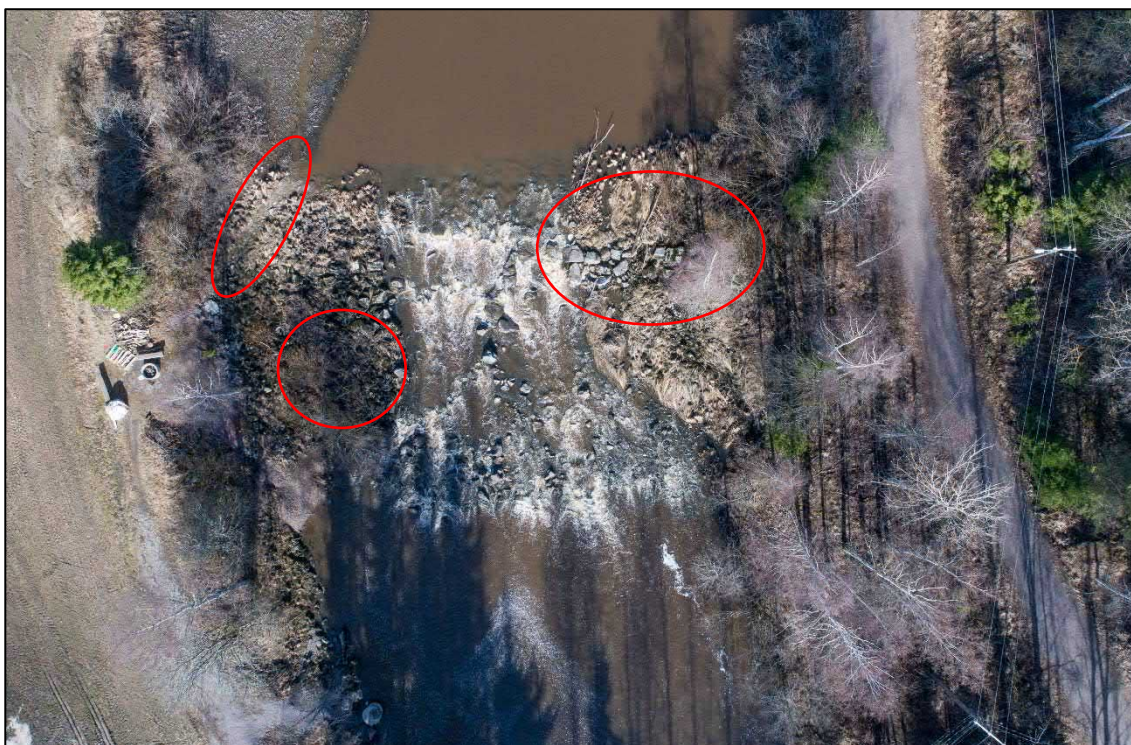
AKDG6208:1 Hurankoski. Myllyn padon jäännöksiä koskessa. Patorakenne, uoma ja mahdollinen rakennuksen pohja ympäröity Dronekuva idästä.
