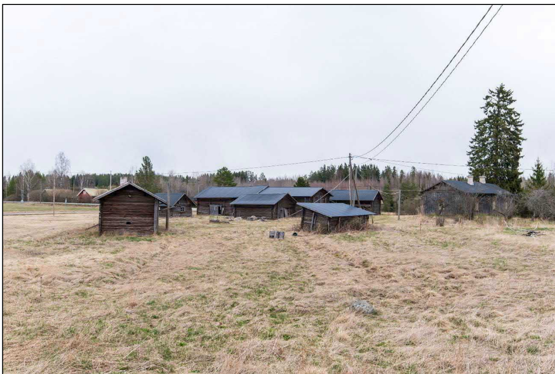
AKDG6212:4 Brusilan vanhoja hirsirakennuksia. Kuva etelästä.
