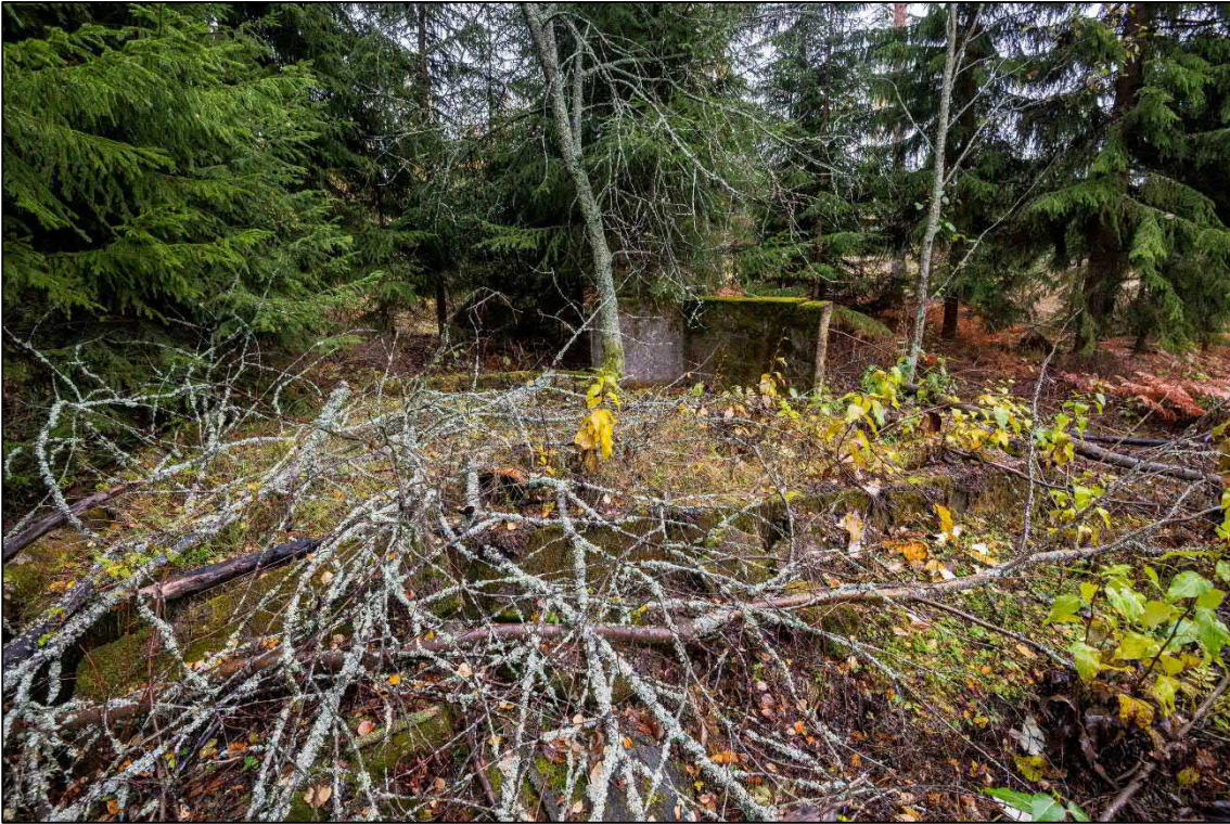
AKDG6311:2 Murronmäki. Uudemman rakennuksen betonisokkeli ja uunin palomuuuri.
