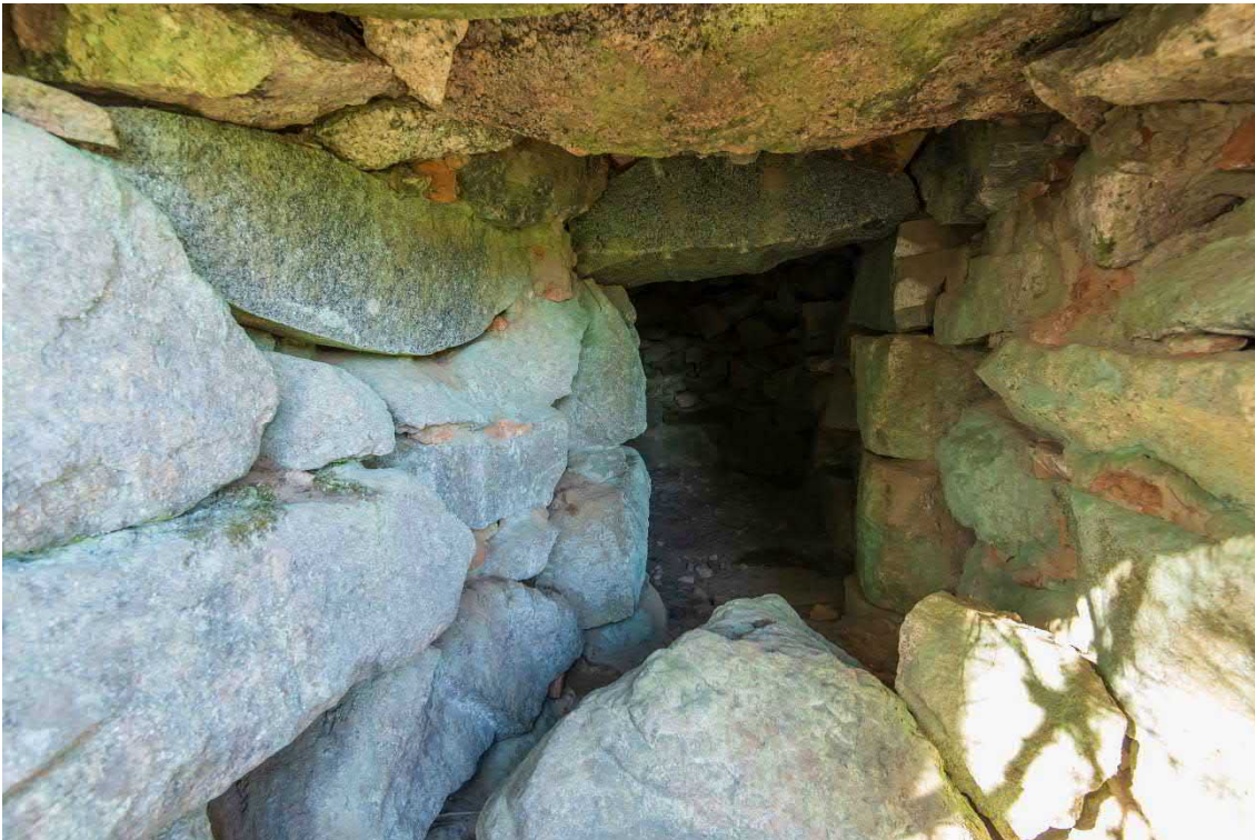
AKDG6305:1 Nikinoja 2. Kivikellarin sisäänkäynti. Kuva etelästä.
