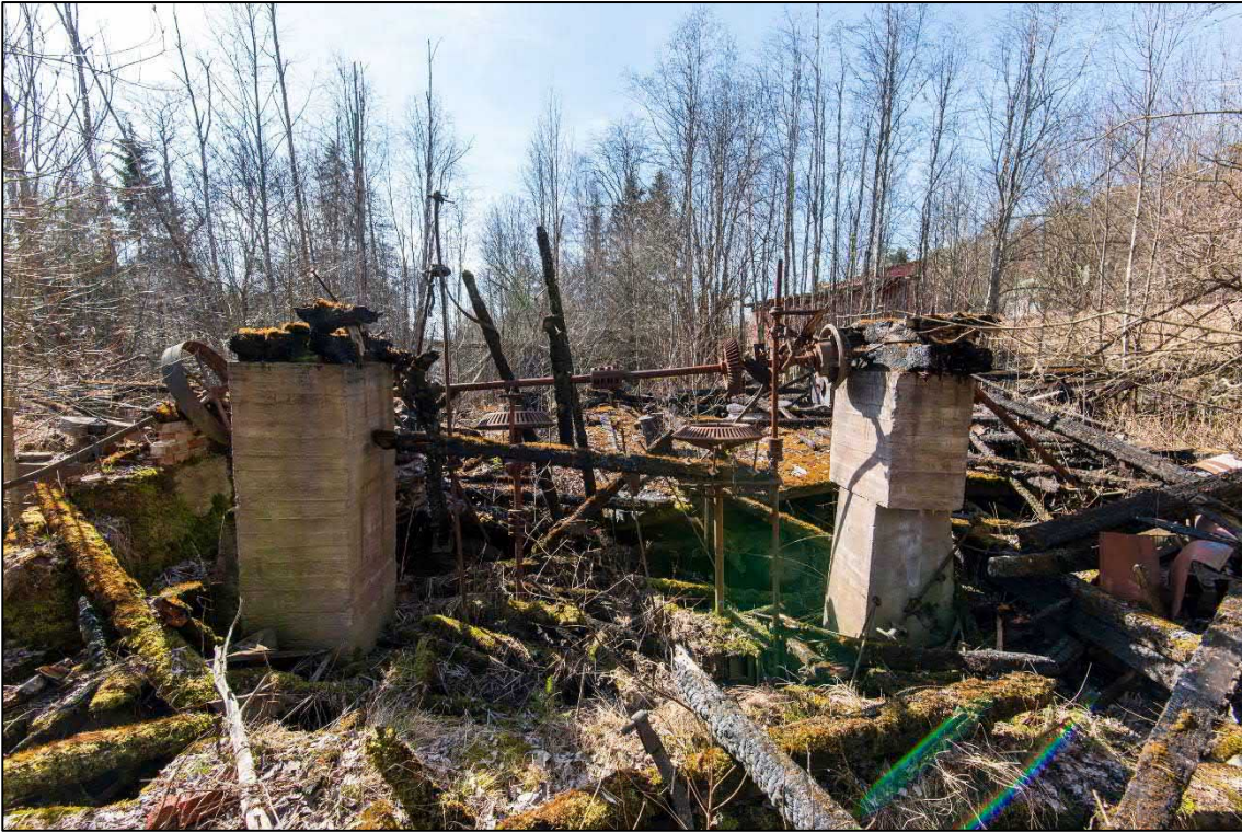
AKDG6253:2 Mäntsälän mylly. Palaneen myllyn jäännökset. Kuva pohjoisesta.
