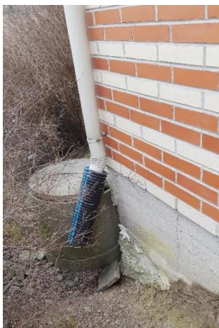
Kuva 3. Sadevesien syöksyputkien alaslaskuja on jatkettu, jotta vesi saadaan ohjattua kauemmaksi sokkelin vierustalta.
