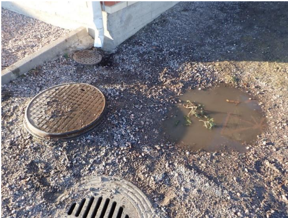
Kuva 27. Sadeveden ohjaus on puutteellinen.
