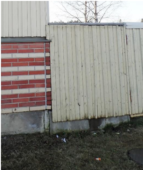
Kuvat 9, 10 ja 11. Tila 199. Ulkoseinällä havaittiin merkkejä kosteusvauriosta.
