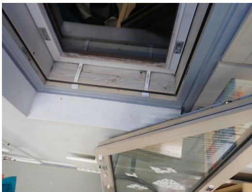
Kuvat 20 ja 21. Tyypillinen ikkunarakenne. Alhaalla keskellä olevaa tuuletusikkunaa lukuun ottamatta ikkunoissa ei ole saranoita.
