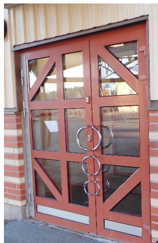
Kuvat 23 ja 24. Ulko-ovien malli. Ulko-ovilehtien välissä on rako, jonka takia ne eivät ole tiiviit ja energiatehokkaat. Ovien ulkoseinäpintoihin kiinnitetyissä peitelistoissa oli rakoja. Muutoin ulko-ovien toimivuudessa ei havaittu puutteita.
