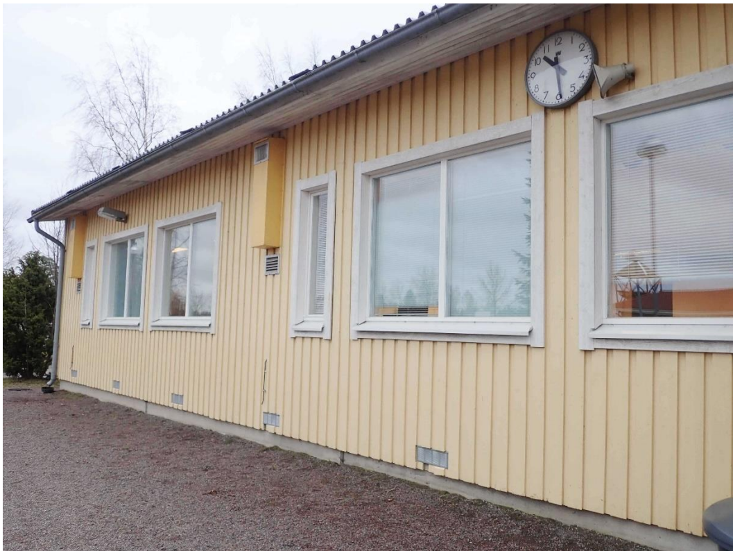
Kuva 18. Puinen julkisivulaudoitus on pääosin kunnossa
