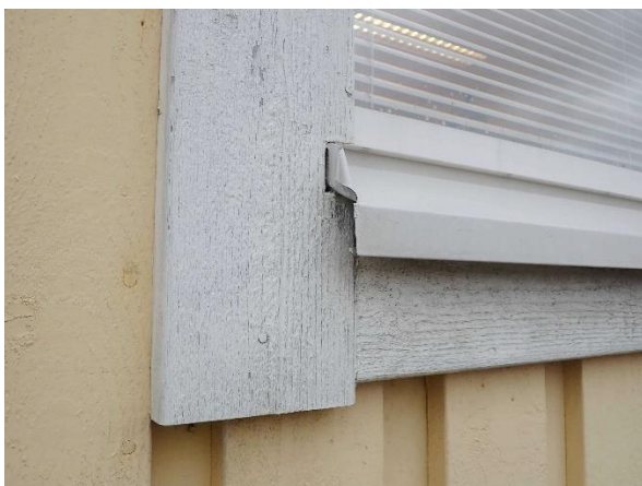
Kuva 27. Räystäspellitysten ylösnostot ovat vesitiiviit
