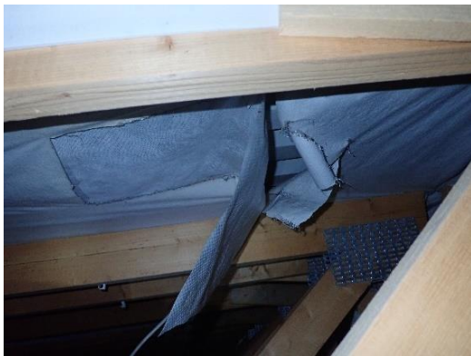
Kuvat 42 ja 43. Aluskate repsottaa monin paikoin. Johtoläpiviennit eivät ole tiiviitä.
