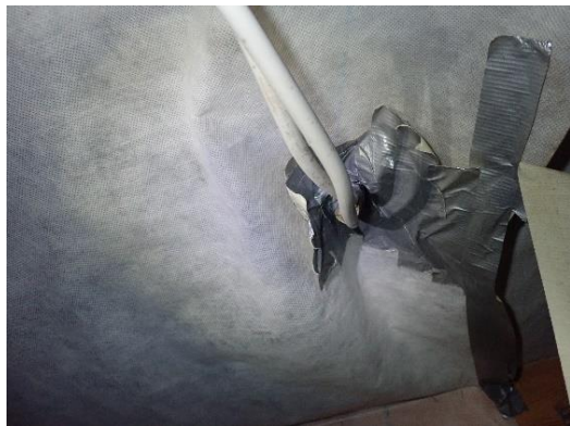
Kuvat 42 ja 43. Aluskate repsottaa monin paikoin. Johtoläpiviennit eivät ole tiiviitä.
