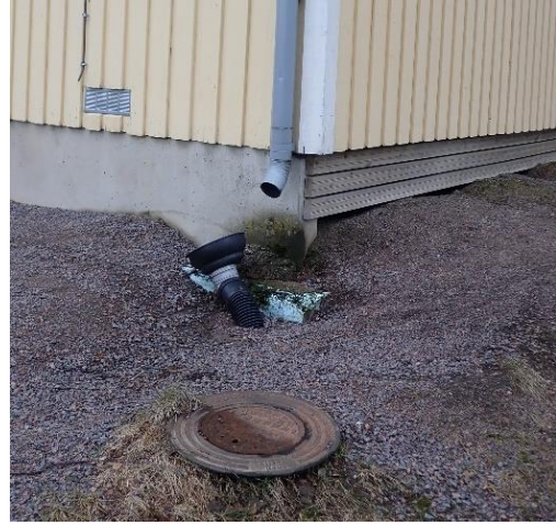
Kuvat 53 ja 54. Sadevesikourujen vedet ohjautuvat sokkelin viereen ja vedenkerääjät ovat pois paikoiltaan.
