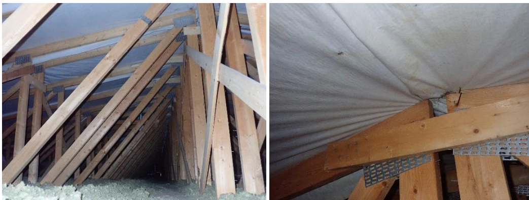
Kuvat 36 ja 37. Yläpohjatilassa kattotuolit ja aluskate ovat yleisesti hyväkuntoisia.
