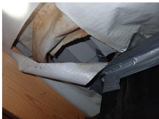
Kuvat 42 ja 43. Aluskate repsottaa monin paikoin. Johtoläpiviennit eivät ole tiiviitä.
