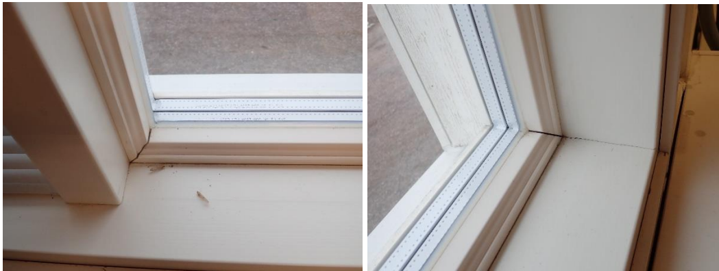
Kuvat 25 ja 26. Ikkunat ovat hyvässä kunnossa.
