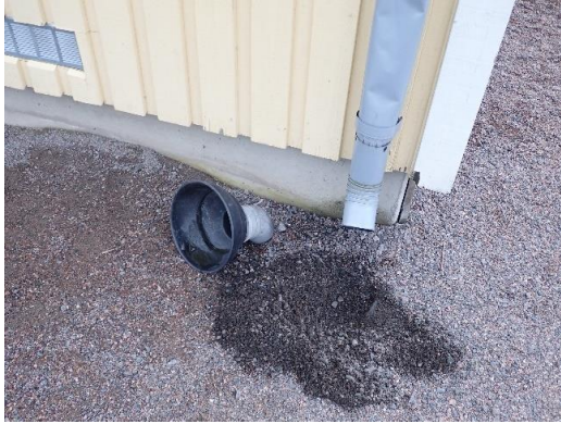
Kuvat 53 ja 54. Sadevesikourujen vedet ohjautuvat sokkelin viereen ja vedenkerääjät ovat pois paikoiltaan.
