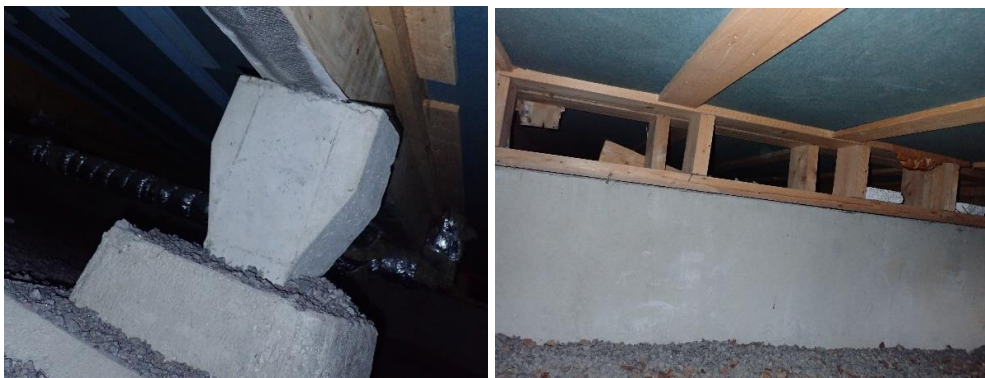
Kuvat 7 ja 8. Alapohjan kantavat puupalkit on tuettu betonianturoilla ja betonisokkelilla. Betonin ja puuosien välissä on irrotuskaista.
