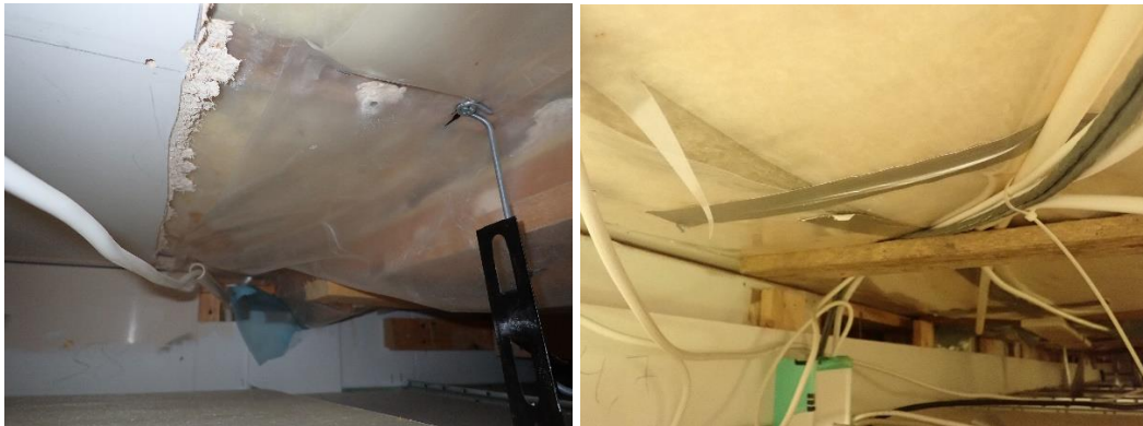
Kuvat 50 ja 51. Aukinaista höyrynsulkua.
