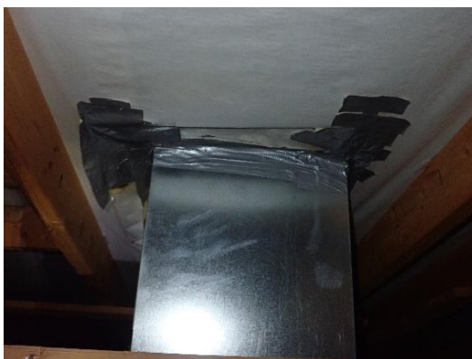
Kuvat 44 ja 45. Epätiivis läpivienti.
