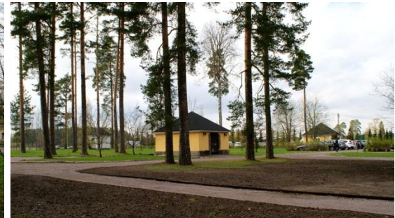
Kuva: Pyramidikattoisia piharakennuksia: taustalla vanhat ulkokuone ja autotalli, edustalla uusi jätekatos.
