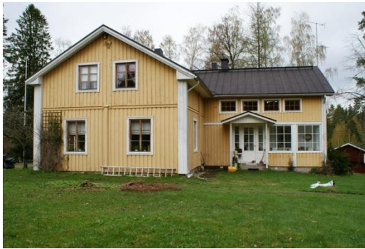
Kuva: Eerolan päärakennus.
