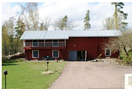
Kuva: Linnamäen aitta-liiteri -rakennus.
