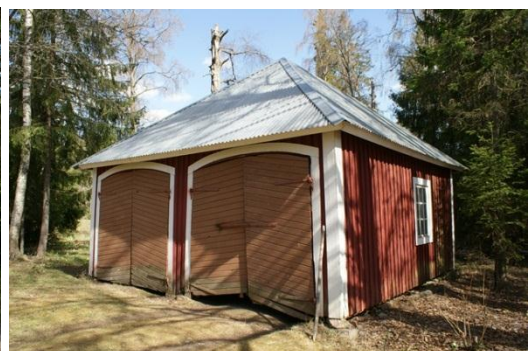
Kuva: Pyramidikattoa on käytetty kylän talojen piharakennuksissa, Lainelassa autotallin kattomuoton
