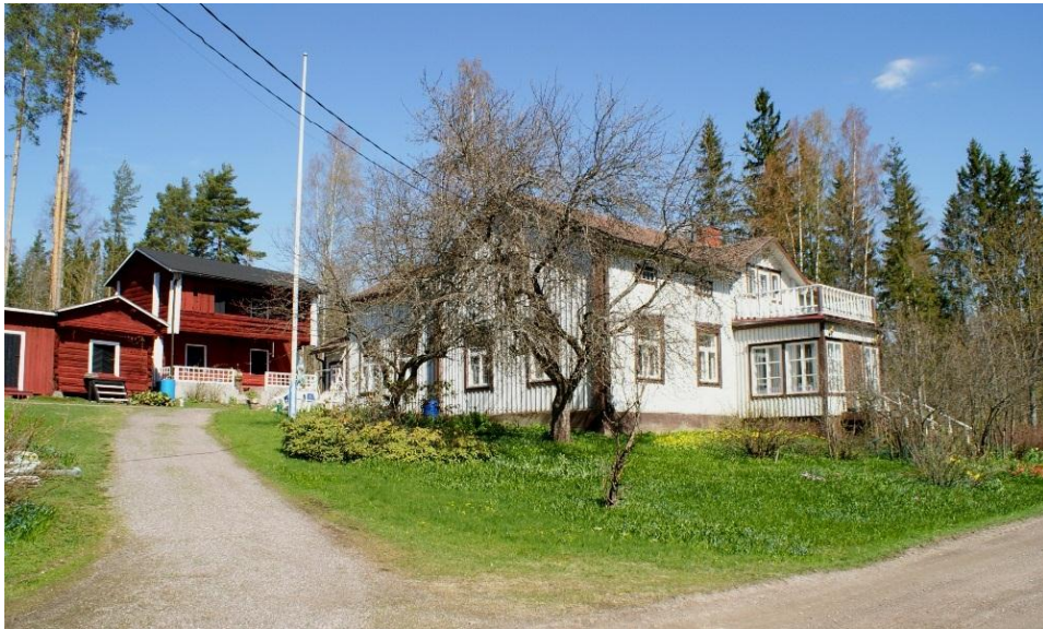
Kuva: Entinen Yli-Eskolan (nykyään Pirkkola) päärakennus ja aittariviä.
