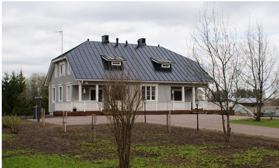
Kuva: Arava peruskorjattuna. Alkuun talo oli ollut vuoraamaton ja hirsiseinät punamullatut, kuten Sillankorvassa.
