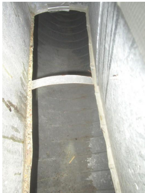
Kuvat 7 ja 8. Vasemmalla näkymä tuloilmakanavaan 1, jonka pohjalla oli epäpuhtauksia, lisäksi kanava on painunut jonkin verran. Oikealla tuloilmakanava 2 ja myös sen pohjalla oli epäpuhtauksia. Kanavissa ei näkynyt mineraalivillaa.
