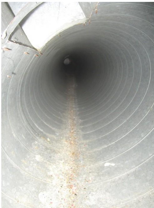
Kuvat 7 ja 8. Vasemmalla näkymä tuloilmakanavaan 1, jonka pohjalla oli epäpuhtauksia, lisäksi kanava on painunut jonkin verran. Oikealla tuloilmakanava 2 ja myös sen pohjalla oli epäpuhtauksia. Kanavissa ei näkynyt mineraalivillaa.
