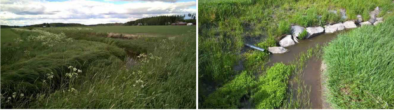
Kuva 40 a ja b. Sortumat ovat muodostaneet uomaan tulvatasanteita ja paikoitellen uoma on eroosiosuojattu kivillä.
