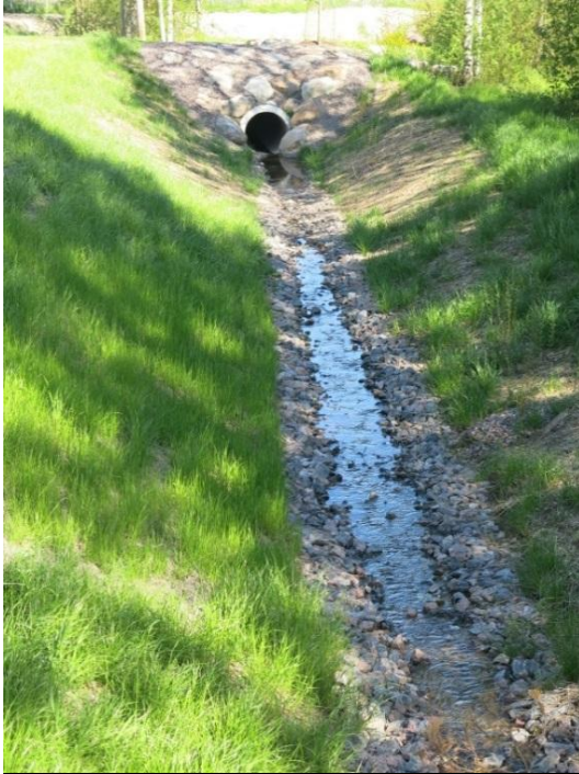
Kuva 7. Kunnostettua ja eroosiosuojattua avouomaa. (Kuvat 4-7: Leena Sänkiaho)
