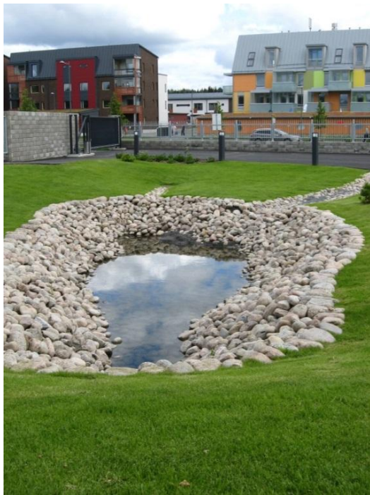
Kuva 4 a. Hulevesien viivytyksallas piha-alueella, lastaus- ja paikoitusalue. b. Hulevesien viivytyksainanne piha-alueella, kerrostalo.
