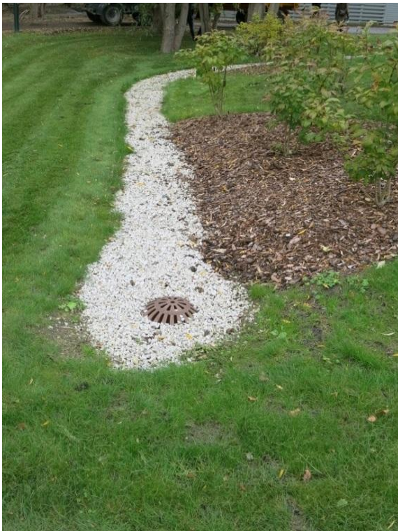
Kuva 6 a. Hulevesien johtamiseen tarkoitettu painanne. b. Matala katukiveys, josta hulevedet pääsevät nurmikolle.
