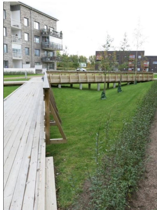
Kuva 4 a. Hulevesien viivytyksallas piha-alueella, lastaus- ja paikoitusalue. b. Hulevesien viivytyksainanne piha-alueella, kerrostalo.
