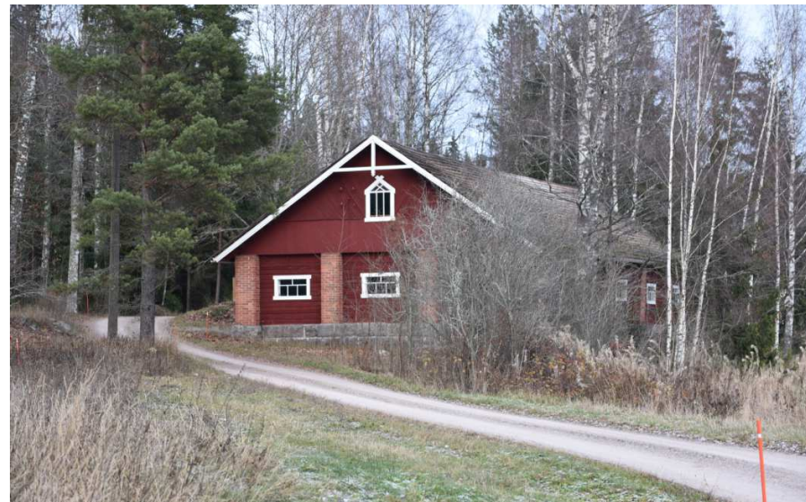
Kuva: Nikinojalla näkyy savitiilestä tai puusta tiilipilareilla rakennettuja maatalousrakennuksia 1900-luvun kolmelta ensimmäiseltä vuosikymmeneltä. Tiiliteollisuutta oli lähellä Oitissa, ja hieman myöhemmin Kärkölen Lappilassa. Kuvassa on Olkisten kylän Jaakkolan navetta.
