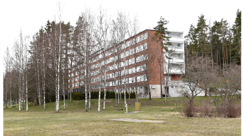
Kuva: Ohkolan entinen B-sairaala, päärakennus.
