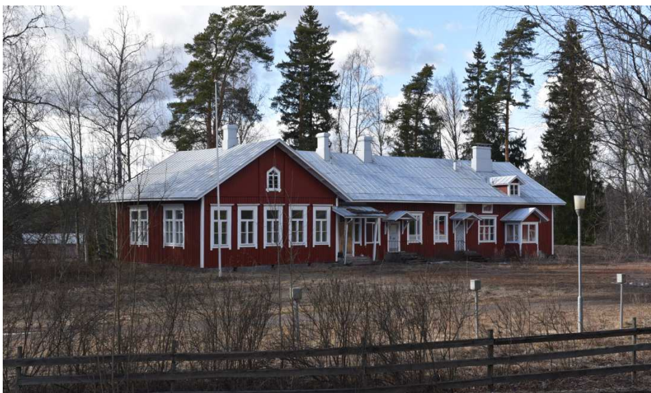
Kuva: Huhtikuussa 1892 Kouluhallitus julkaisi kokoelman ”Mallipiirustuksia kansakoulurakennuksia varten maalla”. Vuonna 1903 valmistunut Hautjärven entinen kansakoulutalo on rakennettu kokoelmaan kuuluvan mallipiirustuksen mukaan, samaa mallia käyttäen myös Soukkion ja Hirvihaaran puukoulut.
