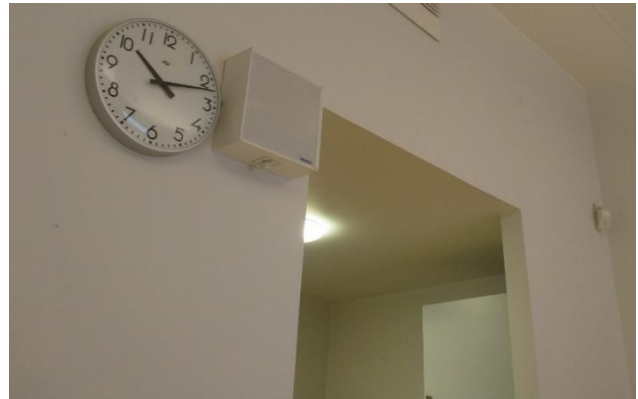
Kuva 70: Väliseinäpintojen yleiskunto oli hyvä tarkastushetkellä, kuva tilasta 174.
