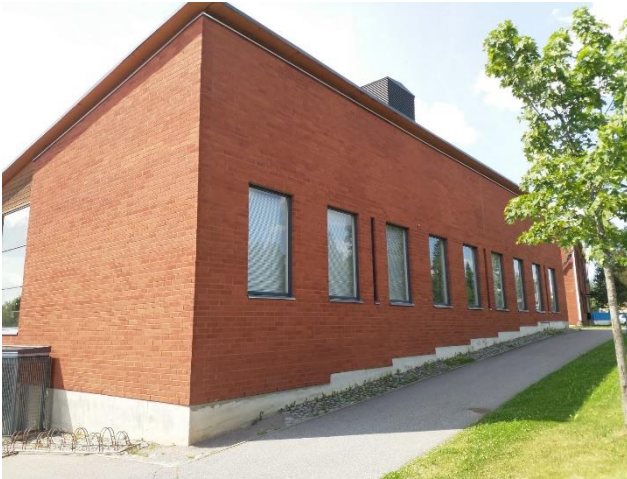
Kuva 46: Laajennusosan tiiliverhous on ehjäkuntoinen.
