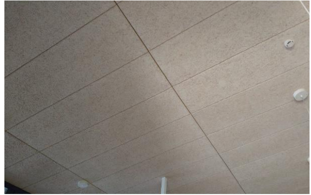
Kuva 72: Myös 1.kerros aulan sisäkattolevyt ovat hyväkuntoisia.
