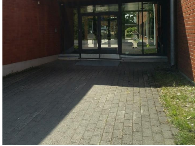
Kuva 7: Koillispuolen sisäänkäynnin ympäristön salaojan tarkastuskaivot käynnin perusteella pihakiveyksen alla.
