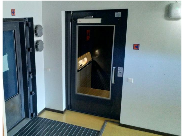
Kuva 41: Laajennusosalla on käytössä yksi hissi.
