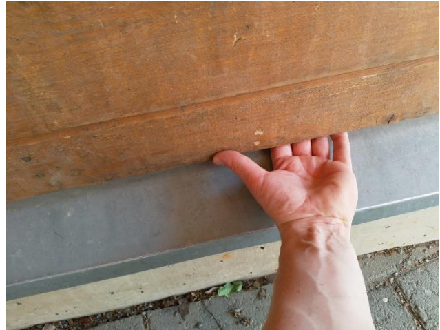
Kuva 47: Paneeliverhouksen taustalle pääsee tuuletusilmaa.
