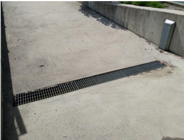
Kuva 10: Laajennusosan eteläpäädyssä luiskan sadevedet ohjautuvat ritiläkaivoon.
