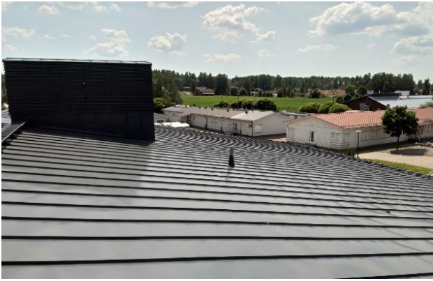
Kuva 63: Vesikate oli tarkastushetkellä hyväkuntoinen.
