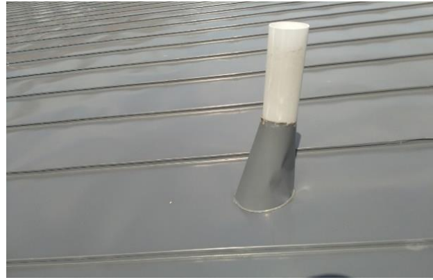
Kuva 64: Vesikaton läpiviennit oli toteutettu tiiviisti.
