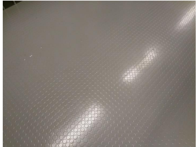
Kuva 25: Lattiapäällyste puu- ja metallityöluokissa. Päällysteessä ei poikkeamia.
