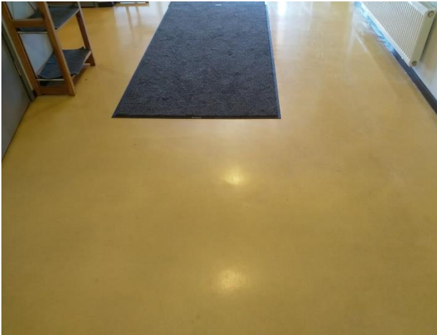
Kuva 24: Alapohjien lattiapäällysteissä ei todettu poikkeamia. Päällysteissä normaalia kulumista.
