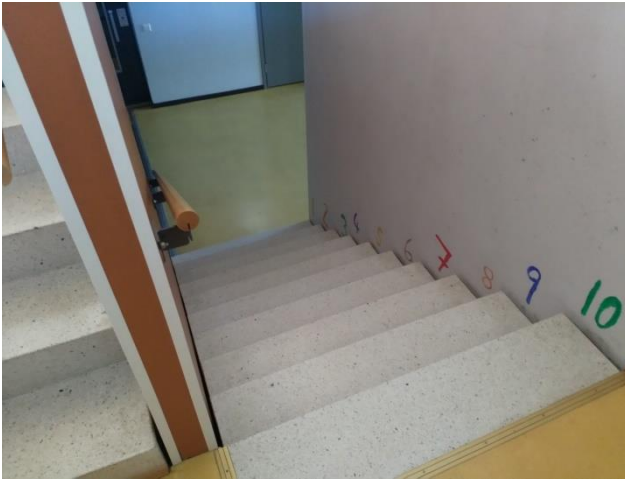
Kuva 40: Portaissa nähtävissä normaalia kulumista. Ei viitteitä kosteus-, mikrobi- tai rakenteellisista vaurioista.
