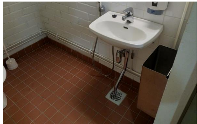
Kuva 75: WC-tilojen pintamateriaalit ovat ehjiä ja hyväkuntoisia.
