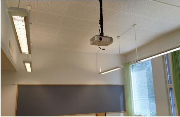
Kuva 71: Sisäkattopinnoilla ei ollut havaittavissa viitteitä kosteus- ja mikrobivaurioista.
