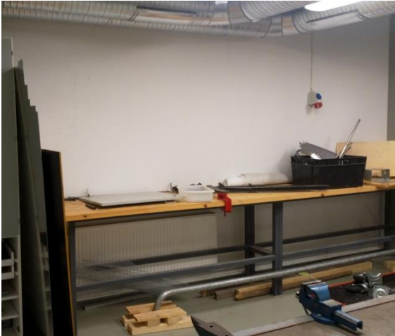
Kuva 16: Maanvastaisissa seinissä ei todettu merkkejä kosteusvaurioista. Seinät ovat yleisesti päällepäin hyväkuntoisia.
