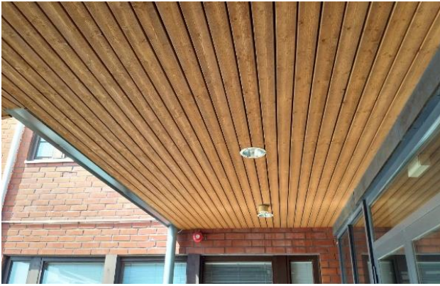
Kuva 57: Katosten aluslaudoitus oli tarkastushetkellä hyväkuntoinen.
