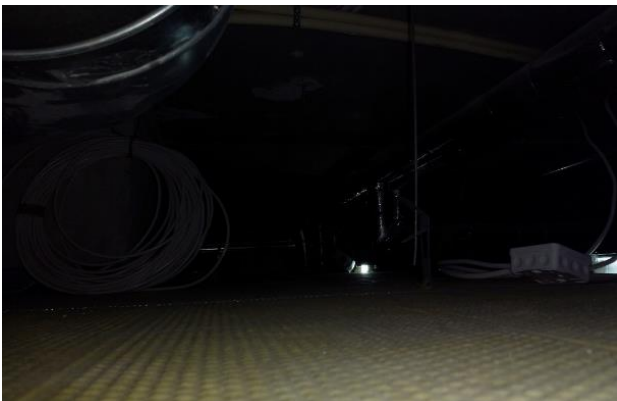
Kuva 73: Kellarikerroksen käytävän alaslasketun katon päällä ei havaittu epäpuhtauksia.
