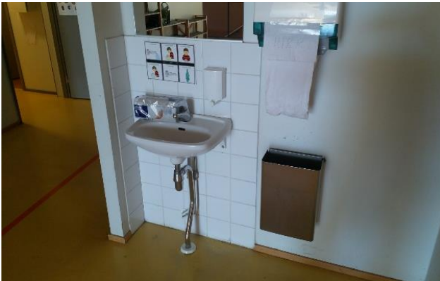
Kuva 69: Kevyissä väliseinissä ei havaittu puutteita. Kuva aulan pesualtaan väliseinästä.
