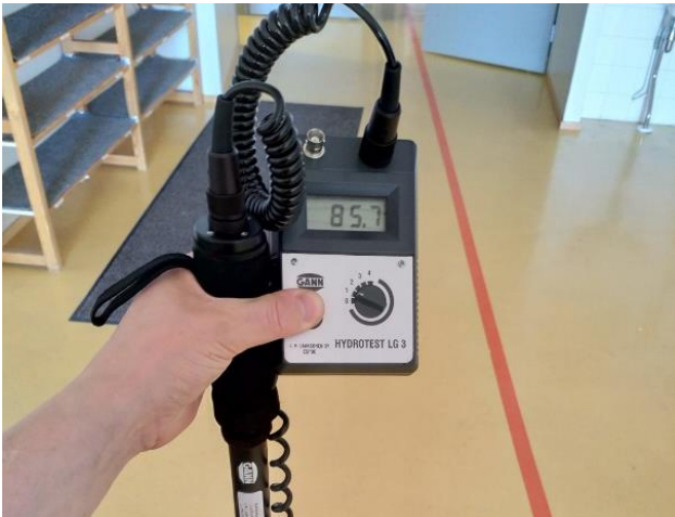
Kuva 38: Välipohjan pintakosteuslukemat olivat paikoin hieman koholla.
