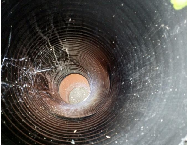
Kuva 6: Laajennusosan lounaisnurkan salaojan tarkastuskaivo oli tarkastushetkellä kuiva.
