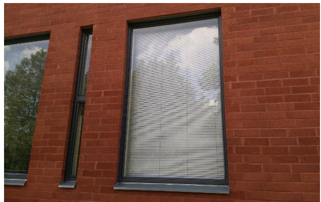
Kuva 53: Ikkunat ovat yleisesti hyväkuntoisia.
