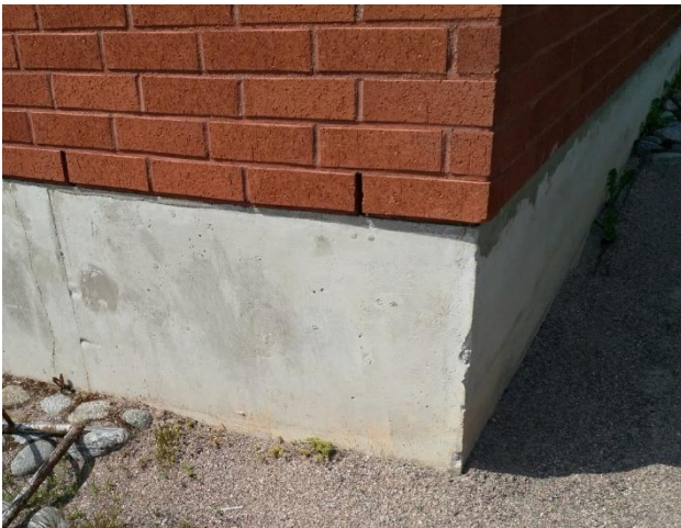
Kuva 48: Tiiliverhouksen alareunassa joka kolmas pystymuuraussaumaa on auki verhouksen tuulettamiseksi.
