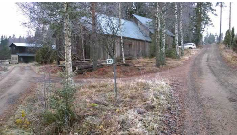
AKDG 5043:53. Rantalan torppa. Etu-Rantalan piharakennuksia, vanha kellari tukkipuiden alla, kaakosta. Kuvaaja: Tuija Väisänen.
