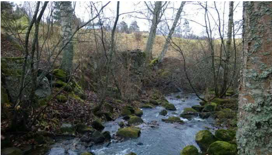
AKDG 5043:99. Sahajärven saha ja mylly. Sahaan liittyviä eri aikaisia rakenteita hajotettuna nykyisten rakennusten ja sillan eteläpuolella, luoteesta. Kuvaaja: Tuija Väisänen.
