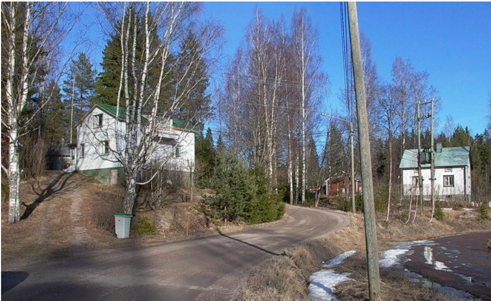
Kuva: Koverontien alkupään puolitoistakerroksisia puutaloja. Rakennuskantaa yhdistää jo ennen viime sotia ja etenkin sen jälkeiselle tyyppirakentamiselle ominainen kompakti neliömäinen hahmo, puolitoistakerroksisuus sekä jyrkähkö harjakatto. / Kaisa Linnasalon raportti, 2004
