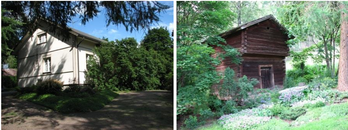
Kuvat: Vanhakartanon päärakennuksen rappaus (kiinnitys tapituksella suoraan hirteen) on korvattu vyöhykkeisellä puuverhouksella. Tienpuoleinen pitkä avoveranta on rakennettu uudelleen vanhaan malliin. Pihanpuoleisesta sivukuistista on tehty aikaisempaa suurempi harjakattoinen umpikuisti. Pihan reunalla on korkeaotsainen yksinäisaitta. (2008)
