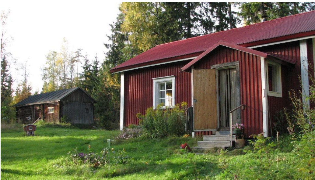
Kuva: Koskelan asuinrakennus ja vanha karjasuoja (2008)
