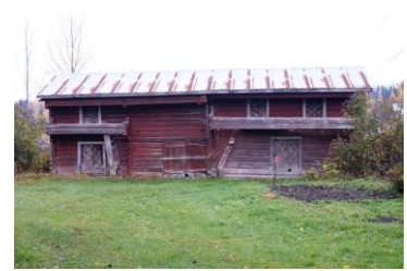
Kuva: Laine-Pietalan komea jykevähirsinen aittarakennus; aitan pätyyn kaiverrettu 183(4).
