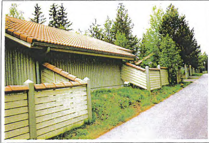
Valokuva 4. Teeritien varren nykyinen tontilaita ja talousrakennus. Ohjeissa pyritään välttämään tämän tyyppistä ratkaisua johon muodostuu n. 2m leveä epäalue. Sen sijaan esitetään että autotalli-talousrakennus rakennetaan kohtisuoraan katuun vasten 5:n metrin etäisyydelle tontin rajasta ja ajo kadulta tapahtuu suoraan talliin. Näin liittymä ja paikoitus muodostavat toiminnallisen kokonaisuuden.
