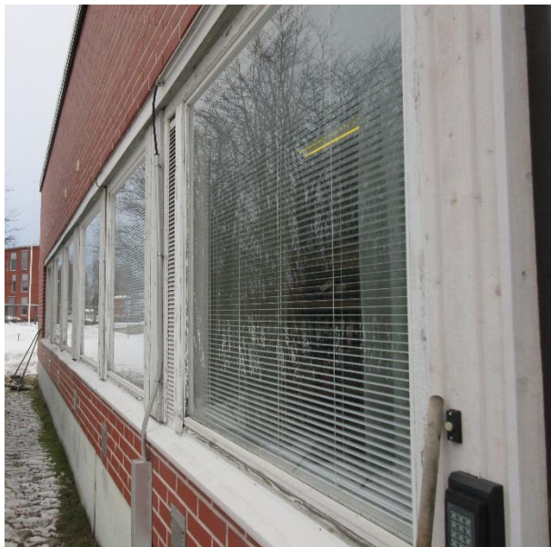
Kuva 15,16: Vanhan osan ikkunat ja väliovet olivat tyydyttävässä kunnossa.
