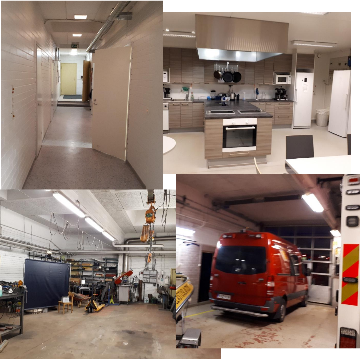
Kuva 19-22: Osa pinnoista oli hyvässä kunnossa, osa kuluneita
