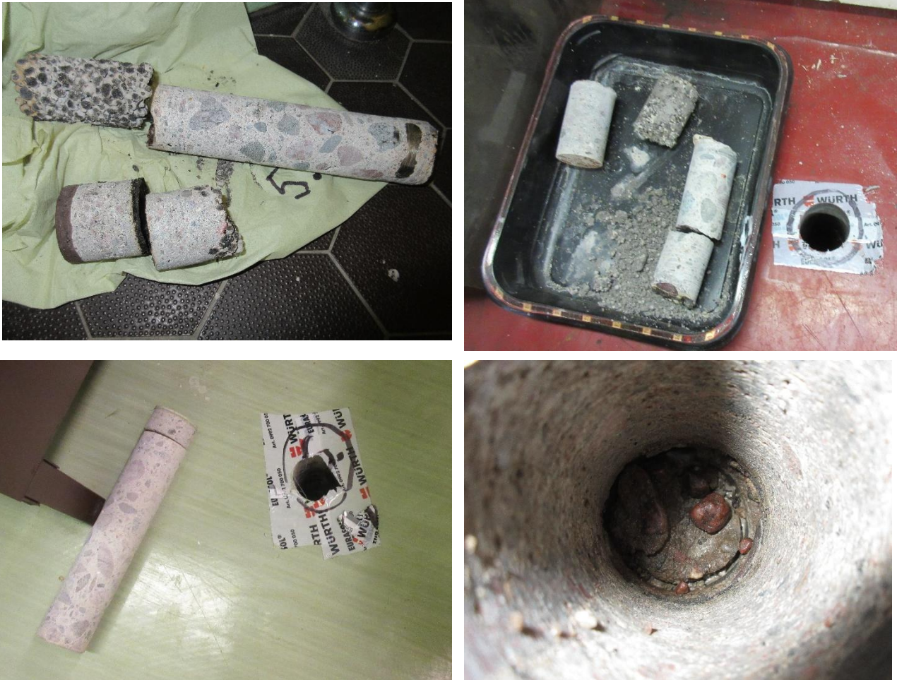
Kuva 3-6: Rakenneavauskohdat RA5, RA3, RA8 ja RA4
