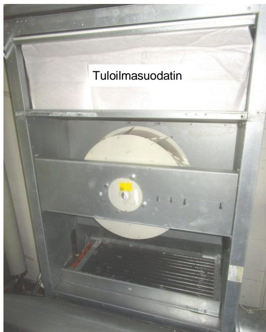
Kuvat 30 ja 31. Tuloilmakone TK01. Tuloilmasuodattimena oli vaalea M5-tasoinen pussisuodatin. Konekotelon sisäpinnassa lämmityspatterin kohdalla on pinnoittamatonta mineraalivillaa kahdessa kohdassa.
