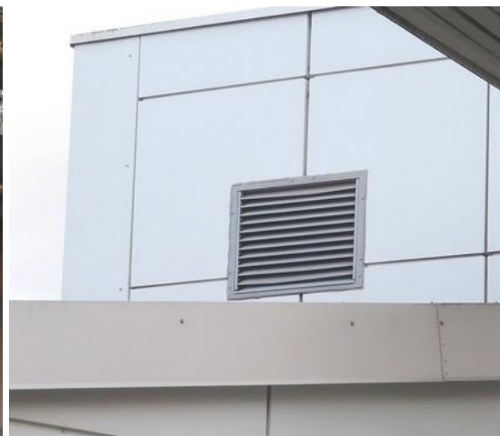
Kuvat 16 ja 17. Ilmanvaihtokone 4TK1 on vuodelta 1991. Ulkoilmasäleikkö on ns. vakiosäleikkö ilman erillistä sääsuojaa.
