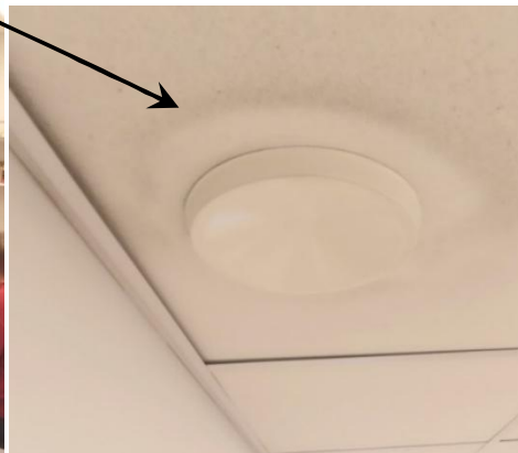
Kuvat 29 ja 30. Vanha osa. Tilaan 127 ei tule tuloilmaa, koska molemmat tuloilmaventtiilit olivat täysin kiinni. Tilaa käytetään säännöllisesti.
