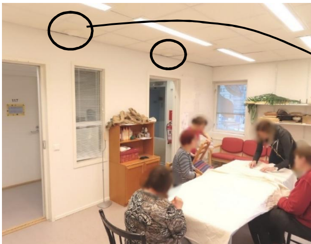
Kuvat 29 ja 30. Vanha osa. Tilaan 127 ei tule tuloilmaa, koska molemmat tuloilmaventtiilit olivat täysin kiinni. Tilaa käytetään säännöllisesti.
