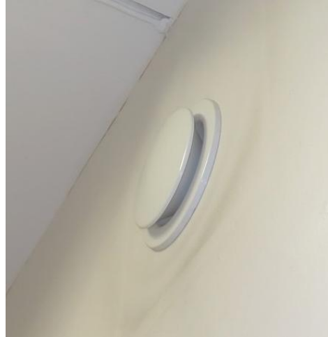
Kuvat 27 ja 28. Vanha osa. Tilan 101 vierisessä toimistohuoneessa tuloilmalaitteena toimii poistoilmaventtiiliksi suunniteltu URH-venttiili. Tuloilma ei kulkeudu työpisteisiin.
