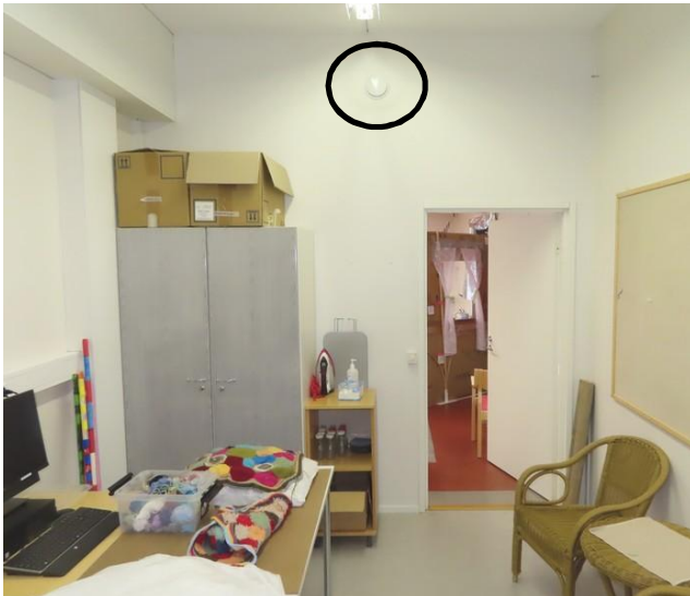
Kuvat 27 ja 28. Vanha osa. Tilan 101 vierisessä toimistohuoneessa tuloilmalaitteena toimii poistoilmaventtiiliksi suunniteltu URH-venttiili. Tuloilma ei kulkeudu työpisteisiin.
