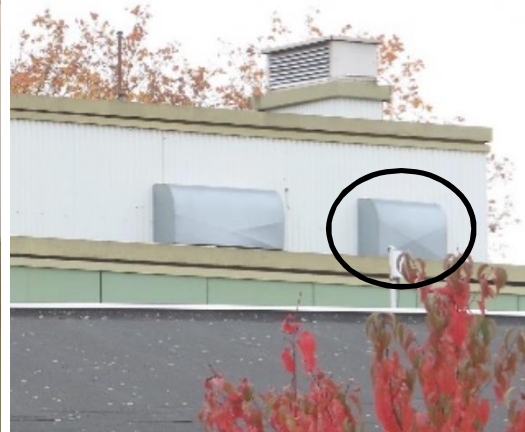
Kuvat 6 ja 7. Ilmanvaihtokone 2TP on todennäköisesti 1960-luvulta. Ulkoilmasäleikön eteen on asennettu erillinen sääsuoja.
