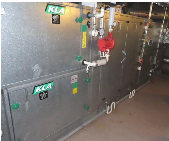
Kuvat 16 ja 17. Ilmanvaihtokone 4TK1 on vuodelta 1991. Ulkoilmasäleikkö on ns. vakiosäleikkö ilman erillistä sääsuojaa.
