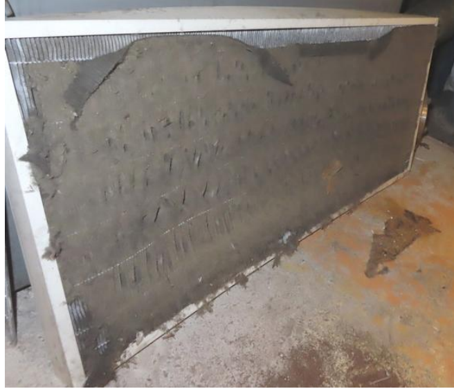
Kuva 13. Tuloilmasuodatin on F7-tasoinen, suodatinkehyksessä oli ohivuotoa. Suodatin oli erittäin likainen.
