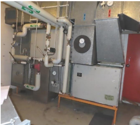
Kuvat 1 ja 2. Ilmanvaihtokone 1TP on todennäköisesti 1960-luvulta. Ulkoilmasäleikön eteen on asennettu erillinen sääsuoja.
