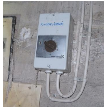
Kuvat 25 ja 26. Vanhan osan tilassa 027 on radon-imuri, jota käytetään tilassa olevasta käsikytkimestä.
