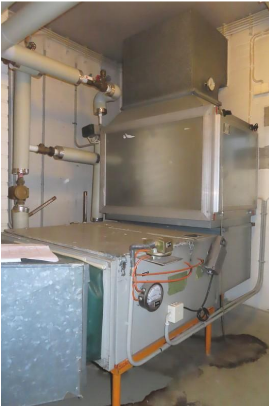
Kuvat 6 ja 7. Ilmanvaihtokone 2TP on todennäköisesti 1960-luvulta. Ulkoilmasäleikön eteen on asennettu erillinen sääsuoja.
