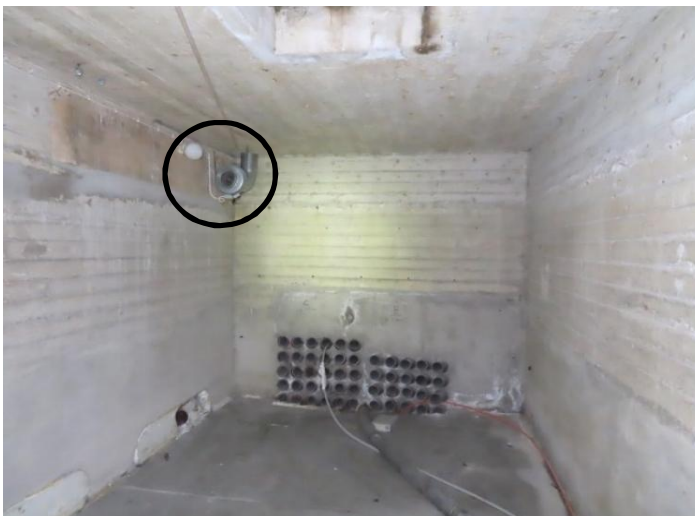
Kuvat 25 ja 26. Vanhan osan tilassa 027 on radon-imuri, jota käytetään tilassa olevasta käsikytkimestä.
