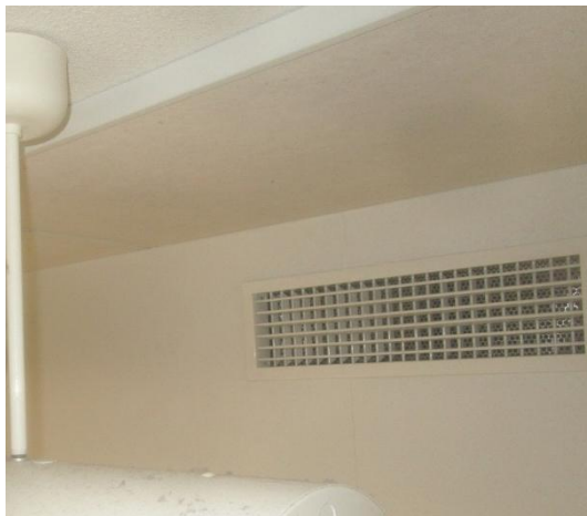
Kuvat 11 ja 12. Koulurakennuksen opetustilojen tyypillinen tuloilman päätelaite, jonka hajotinosassa ei ole mineraalivillaa.
