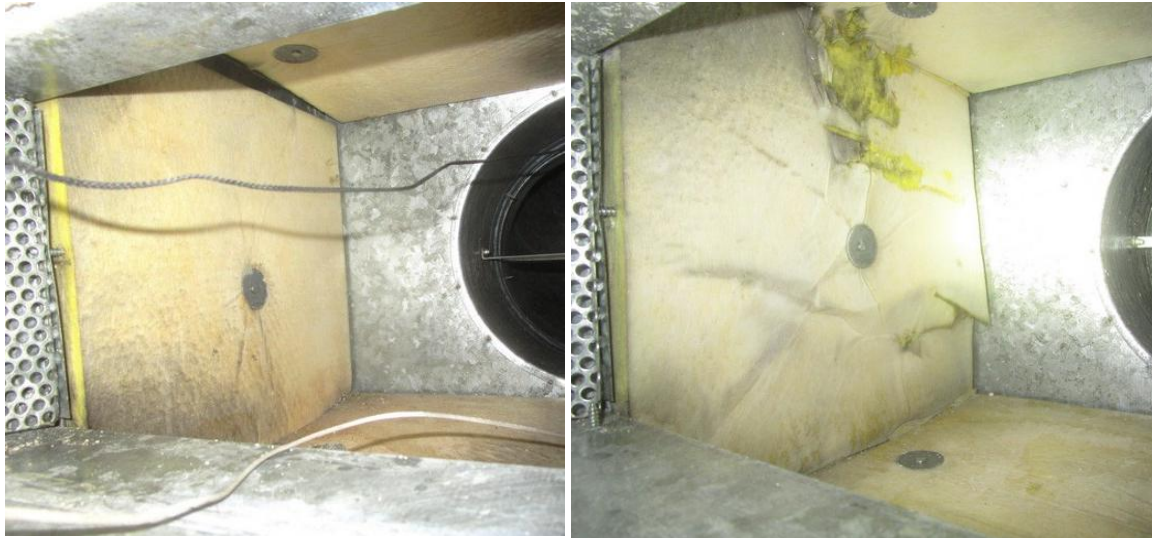
Kuvat 13 ja 14. Koulurakennus. Näkymiä tuloilman päätelaitteen liitäntälaatikon sisään opetustilassa 143 (vasemmalla) ja opetustilassa 202 (oikealla). Laatikoiden sisäpinoilla on reunoilta pinnoittamatonta mineraalivillaa. Lisäksi opetustilassa 202 mineraalivillan pinnoite oli paikoin rikki.
