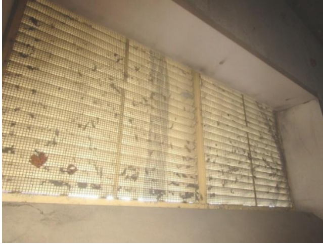
Kuvat 2 ja 3. Ulkoilmasäleikön metalliverkkoon on kertynyt linnunhöyheniä ja muita epäpuhtauksia. Ulkoilmakammiossa on lattiakaivo. Kammion katossa ja seinissä on tummunutta pinnoittamatonta mineraalivillaa.
