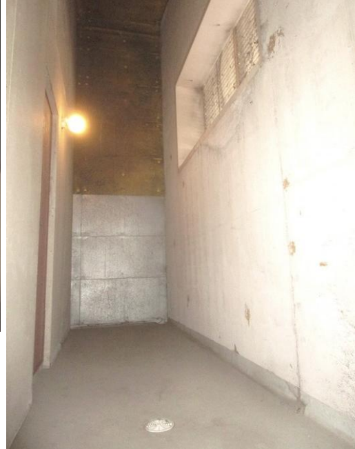
Kuvat 2 ja 3. Ulkoilmasäleikön metalliverkkoon on kertynyt linnunhöyheniä ja muita epäpuhtauksia. Ulkoilmakammiossa on lattiakaivo. Kammion katossa ja seinissä on tummunutta pinnoittamatonta mineraalivillaa.
