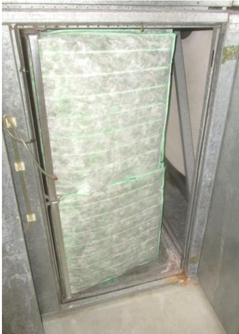
Kuvat 4 ja 5. Tuloilmasuodattimena oli F7-tasoinen pussisuodatin, jonka kehyksessä oli vähäistä ohivuotoa. Suodatinosan pohjalla oli vanhoja kosteusjälkiä. Suodattimen jälkeisen pyörivän lämmöntalteenottolaitteen lamellien pölyn määrä oli vähäinen.
