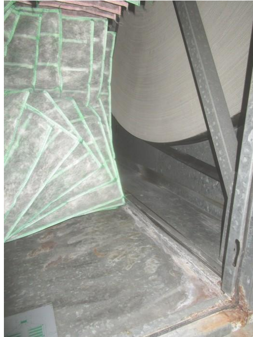
Kuvat 4 ja 5. Tuloilmasuodattimena oli F7-tasoinen pussisuodatin, jonka kehyksessä oli vähäistä ohivuotoa. Suodatinosan pohjalla oli vanhoja kosteusjälkiä. Suodattimen jälkeisen pyörivän lämmöntalteenottolaitteen lamellien pölyn määrä oli vähäinen.
