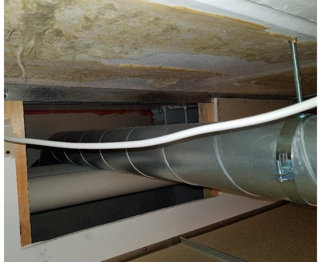
Kuva 3-4: Läpiviennit oli tilkitty mineraalivillalla ja yläpohjalaatassa oli vanhan liimatun villalevyn jäämiä. Käytävän ja toimistotilan väliillä on selkeä ilmayhteys alakaton yläpuolella.
