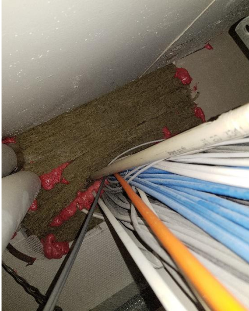
Kuva 3-4: Läpiviennit oli tilkitty mineraalivillalla ja yläpohjalaatassa oli vanhan liimatun villalevyn jäämiä. Käytävän ja toimistotilan väliillä on selkeä ilmayhteys alakaton yläpuolella.
