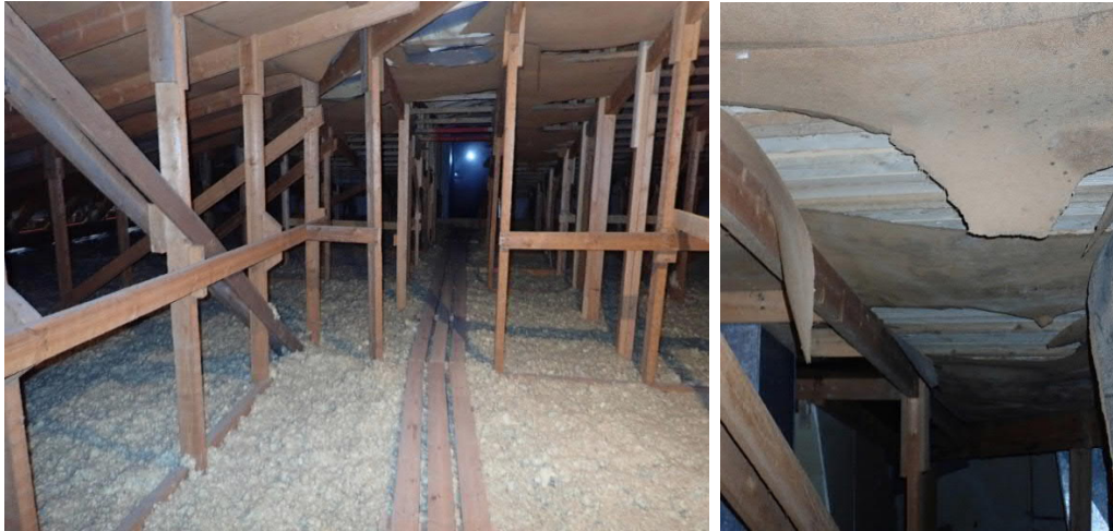
Kuva 2. Vesikaton alla on tuulettuva ullakkotila, jonne on sijoitettu IV-konehuoneet.
