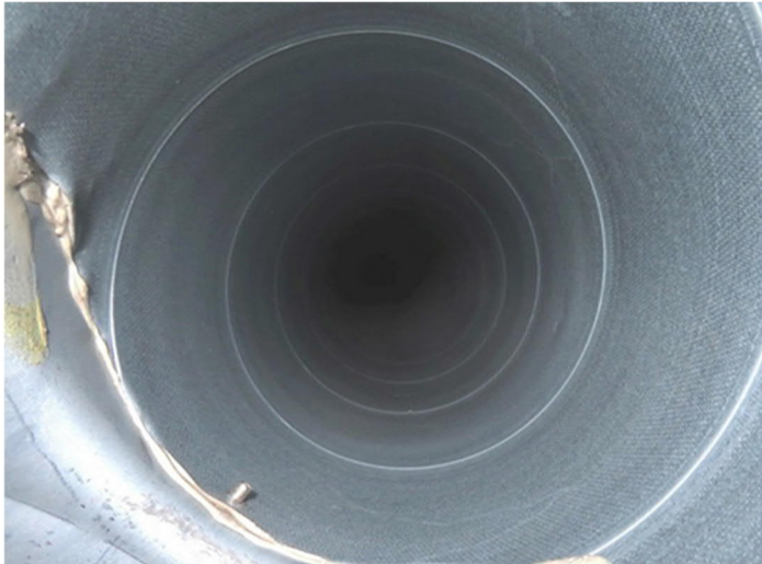
Kuva 10. Arviointipiste KP1, tuloilmakanava käytävällä 1096, sisäpinnan pölykertymäarvio alle 1 g/m 2 .
