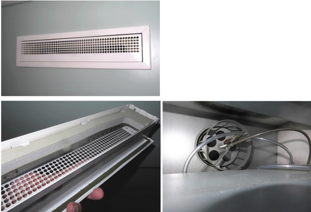
Kuva 14. Tyypillinen huonetilan tuloilman päätelaite, jossa ei ole mineraalivillaa.
