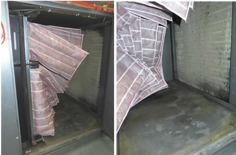
Kuva 7. Kuvissa näkyvä tuloilmasuodatin oli F7-tasoinen, suodatinkehys oli tiivis. Suodatinosan pohjalla oli jonkin verran vanhoja kuivuneita kosteusjälkiä. Tuloilmapuolen lämmöntalteenottopatterin lamelleihin on kertynyt hieman epäpuhtauksia.
