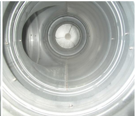
Kuva 12. Arviointipiste KP2, tuloilmakanava tietotekniikkatilassa 103. Sisäpinnan pölykertymäarvio alle 1 g/m 2 . Pöly ei kasaantunut sormella pyyhittäessä.
