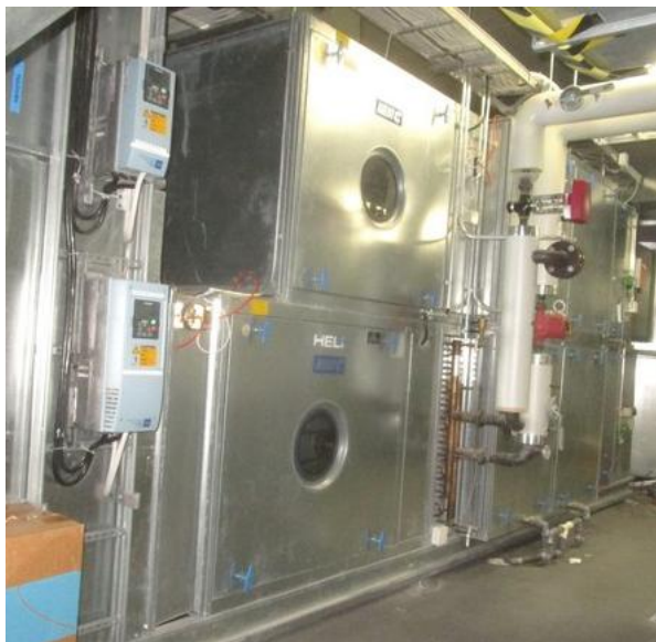
Kuvat 9 ja 10. Ilmanvaihtokone TK04.
