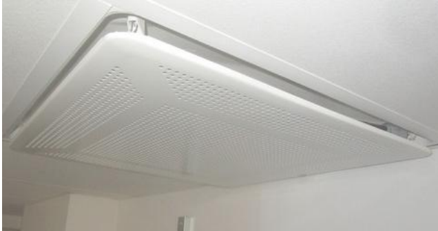
Kuvat 19 ja 20. Opetuskeittiö 129b. Tuloilman päätelaitteiden vaimennusmateriaalina on polyesterimateriaali, mineraalivillaa ei ole.
