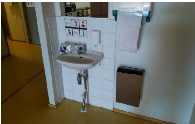
Kuva 93: Kevyissä väliseinissä ei havaittu puutteita. Kuva aulan pesualtaan väliseinästä.
