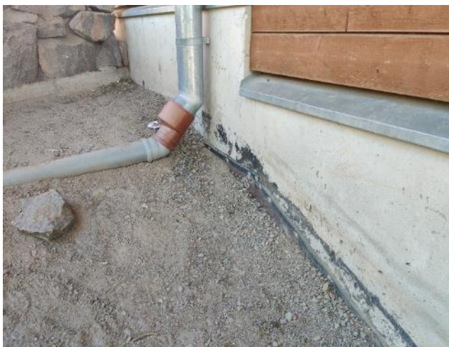
Kuva 29. Länsipuolella rakennusta havaittiin patolevytyks sokkelin vedeneristeenä. Patolevy on paikoin selkeästi maanpinnan alapuolella.
