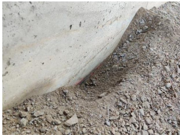
Kuva 10. Pystysalaojakerroksessa on hienoa hiekkaa.
