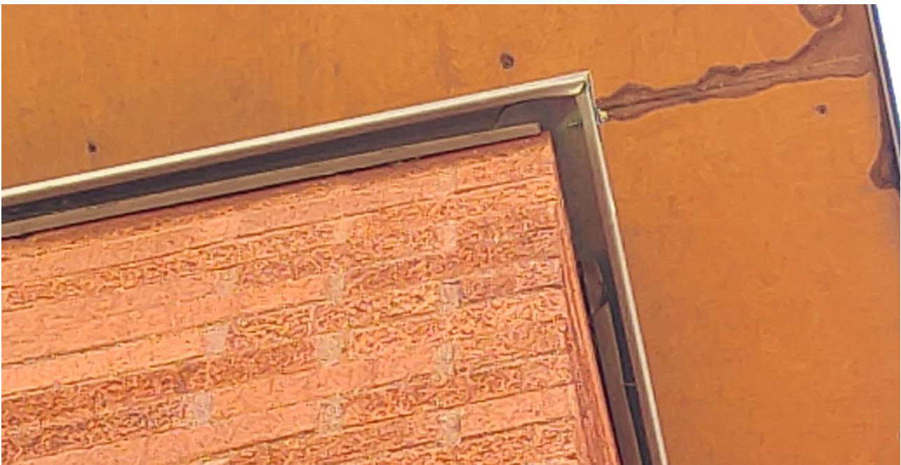
Kuva 67. Tiiliseinän US3 yläosassa on myrskypellitys.
