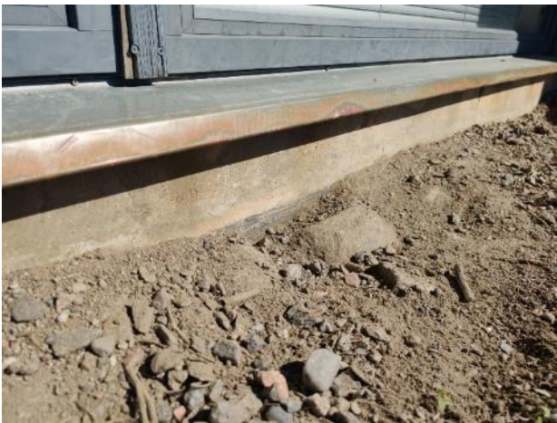
Kuva 9. Pystysalaojakerroksessa on hienoa hiekkaa.
