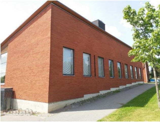
Kuva 60: Laajennusosan tiiliverhous on ehjäkuntoinen.
