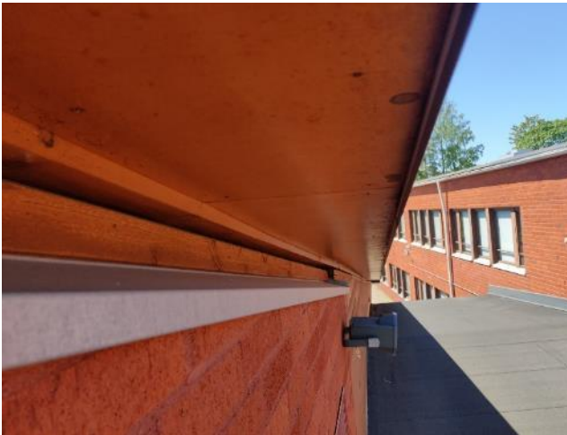
Kuva 95. Rästään alla sijaitseva yläpohjan tuuletusaukko.
