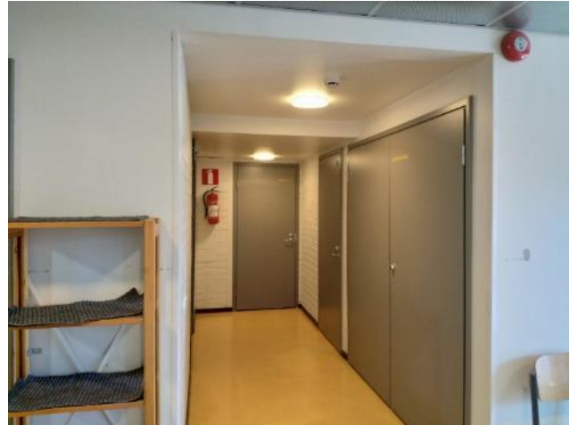
Kuva 42: Kellarikerroksen väliseinät ovat betoni- ja tiilirakenteisia. Seinissä ei ollut merkkejä kosteus-, mikrobi- tai rakenteellisista vaurioista.
