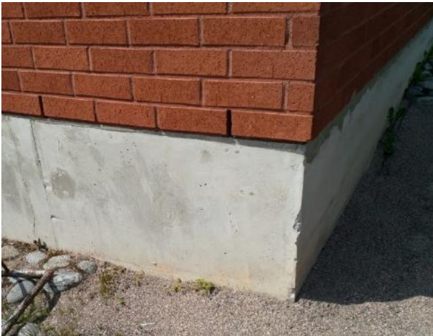
Kuva 62: Tiiliverhouksen alareunassa joka kolmas pystymuuraussauma on auki verhouksen tuulettämiseksi.
