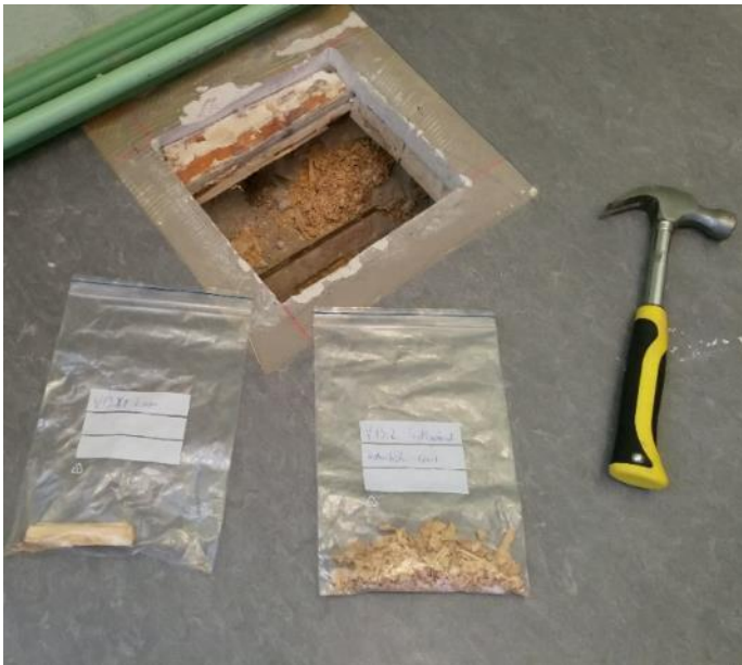
Esimerkkikuva. Rakennusmateriaalinäytteenotto suoraviljelyanalyysiä varten (FCG Oy).
