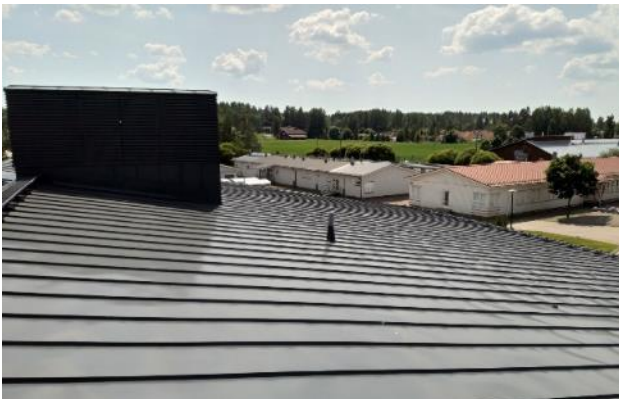
Kuva 86: Vesikate oli tarkastushetkellä hyväkuntoinen.
