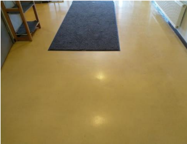
Kuva 35: Alapohjien lattiapäällysteissä ei todettu poikkeamia. Päällysteissä normaalia kulumista.
