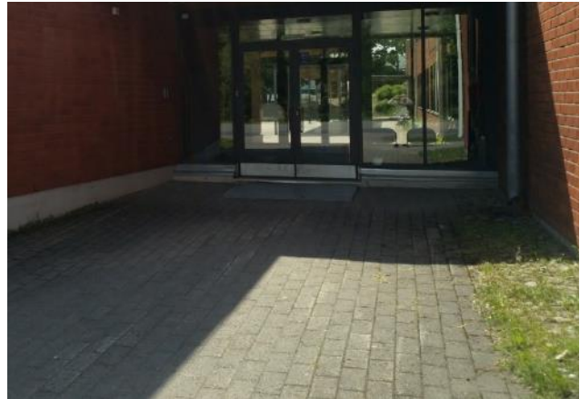
Kuva 8: Koillispuolen sisäänkäynnin ympäristön salaojan tarkastuskaivot käynnin perusteella pihakiveyksen alla.
