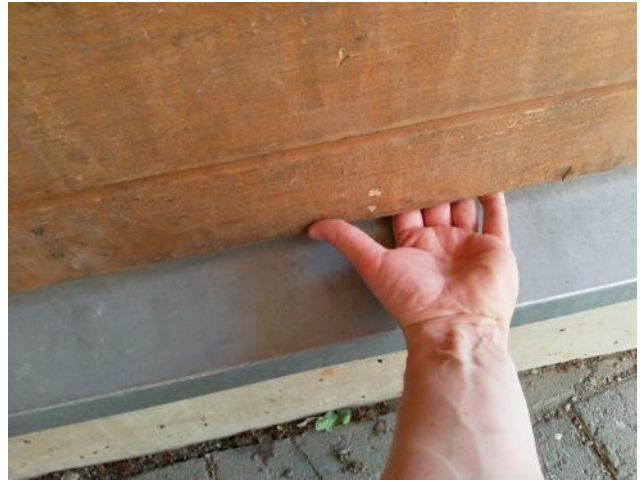
Kuva 61: Paneeliverhouksen taustalle pääsee tuuletusilmaa.
