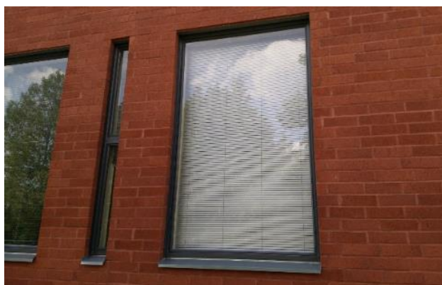
Kuva 74: Ikkunat ovat yleisesti hyväkuntoisia.
