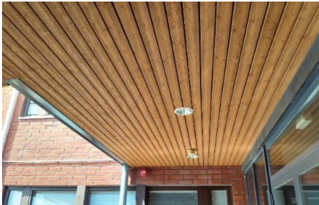
Kuva 78: Katosten aluslaudoitus oli tarkastushetkellä hyväkuntoinen.
