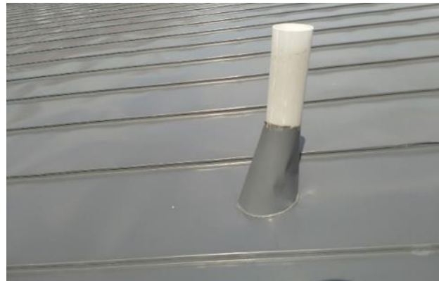
Kuva 87: Vesikaton läpiviennit oli toteutettu tiiviisti.
