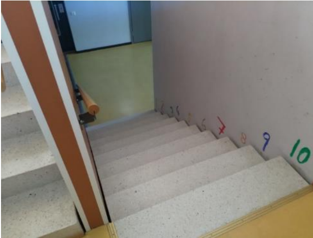
Kuva 54: Portaissa nähtävissä normaalia kulumista. Ei viitteitä kosteus-, mikrobi- tai rakenteellisista vaurioista.
