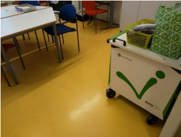
Kuva 47: Välipohjan lattiapäällysteissä ei yleisesti havaittu poikkeamia.
