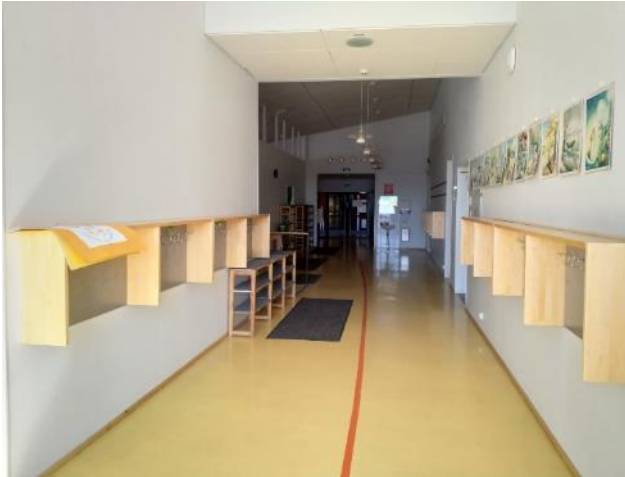
Kuva 41: Väliseinät ovat yleisilmeeltään ehjiä ja hyväkuntoisia.
