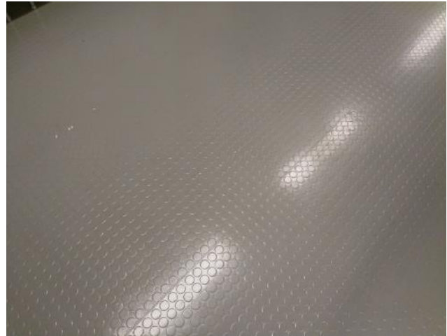
Kuva 36: Lattiapäällyste puu- ja metallityöluokissa. Päällysteessä ei poikkeamia.
