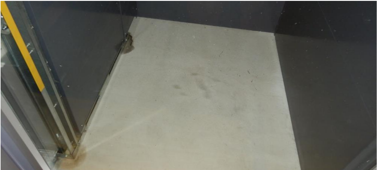
Kuva 56. Hissikuilun pohja oli puhdas.
