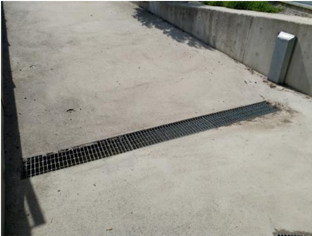
Kuva 13: Laajennusosan eteläpäädyssä luiskan sadevedet ohjautuvat ritiläkaivoon.
