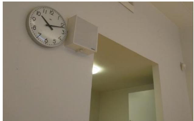
Kuva 94: Väliseinäpintojen yleiskunto oli hyvä tarkastushetkellä, kuva tilasta 174.
