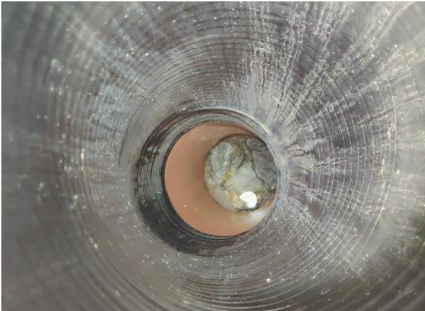
Kuva 7: Laajennusosan lounaisnurkan salaojan tarkastuskaivo oli tarkastushetkellä kuiva.
