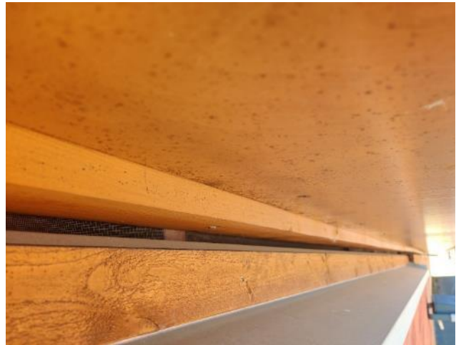
Kuva 96. Rästään alla sijaitseva yläpohjan tuuletusaukko.
