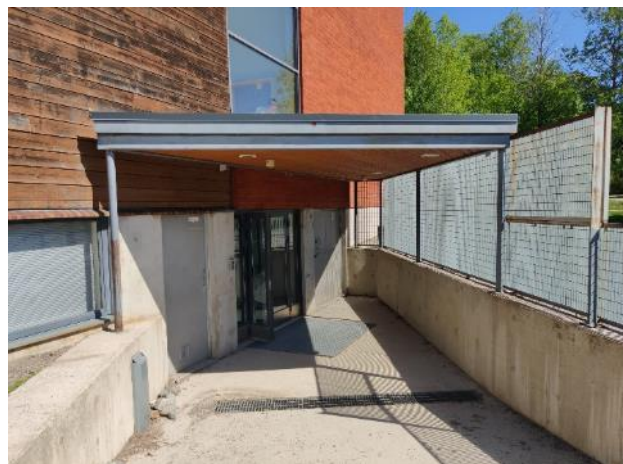
Kuva 59: Päätyseinä ja katos.
