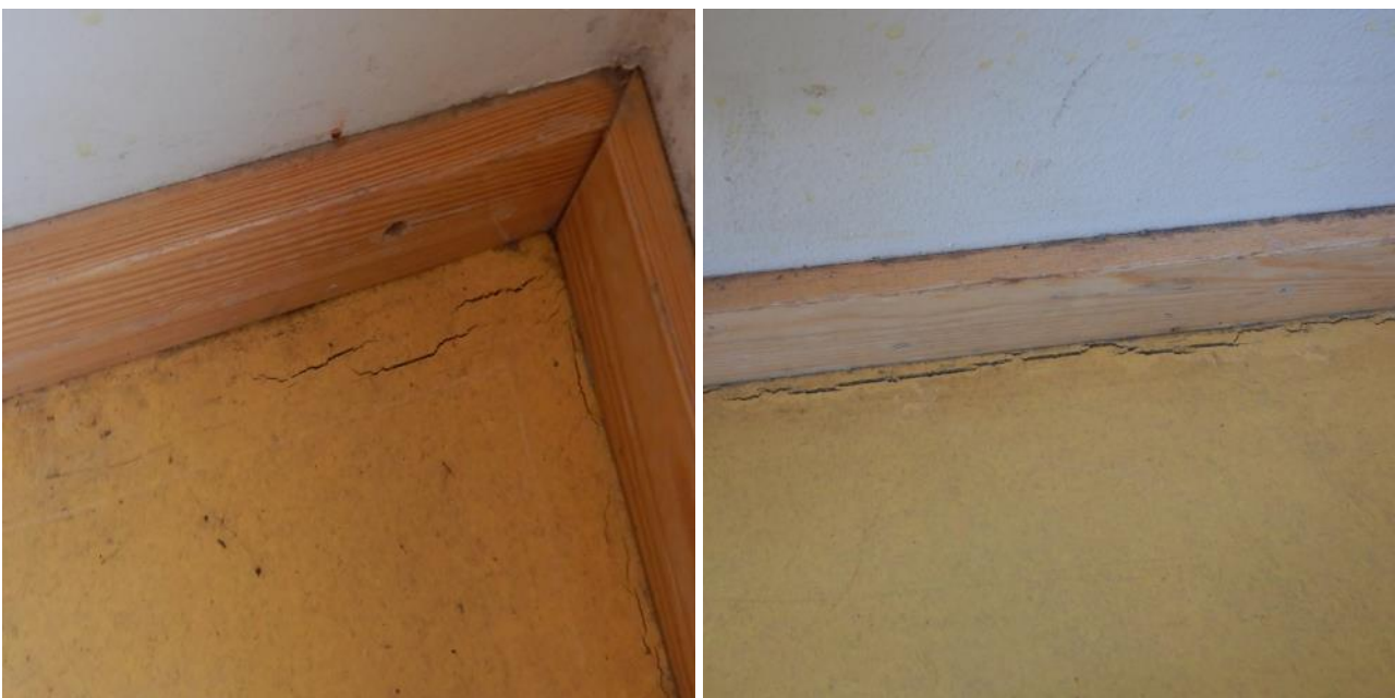
Kuva 98. Muovimatoissa toistuvaa halkeilua väliseinien lähetyillä.
