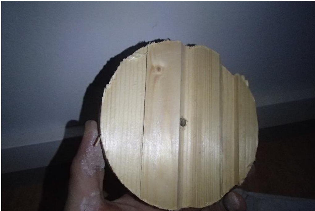
Kuva 36. Välipohjan lattialankkuja alapinnoilla ei havaittu vaurioita.
