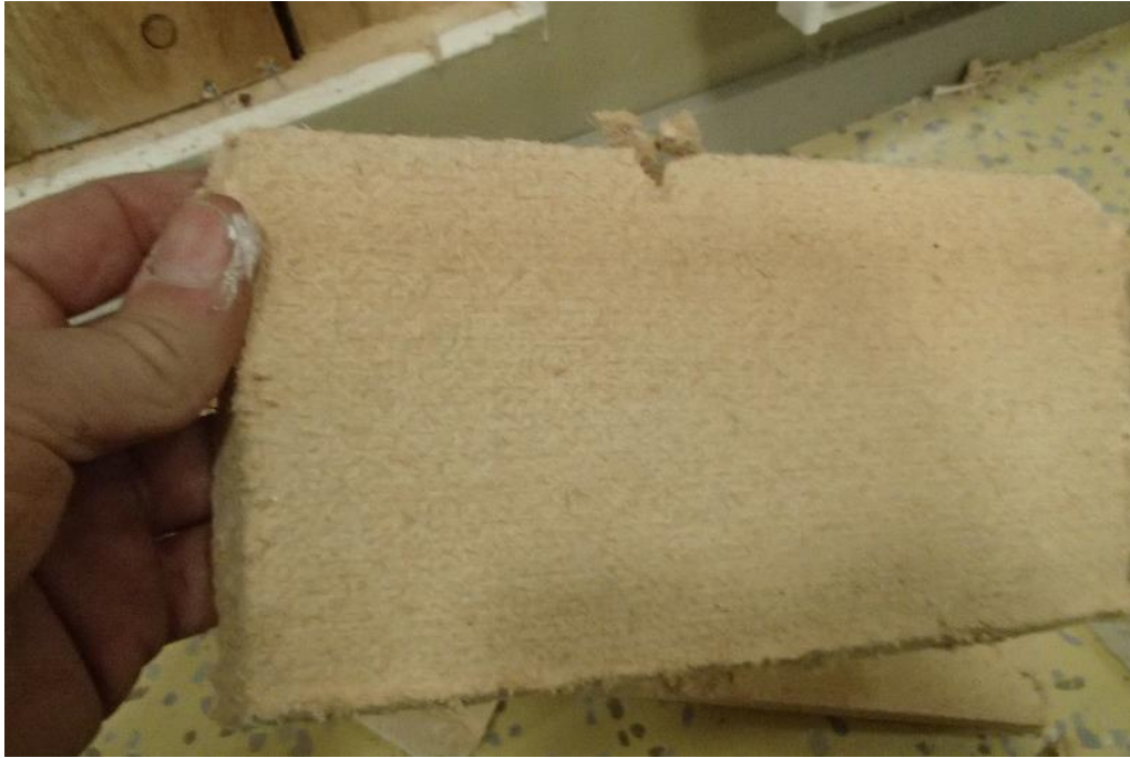
Kuva 73. Rakenneaavausten yhteydessä ei havaittu huokoslevyjien pinnoilla vaurioita.
