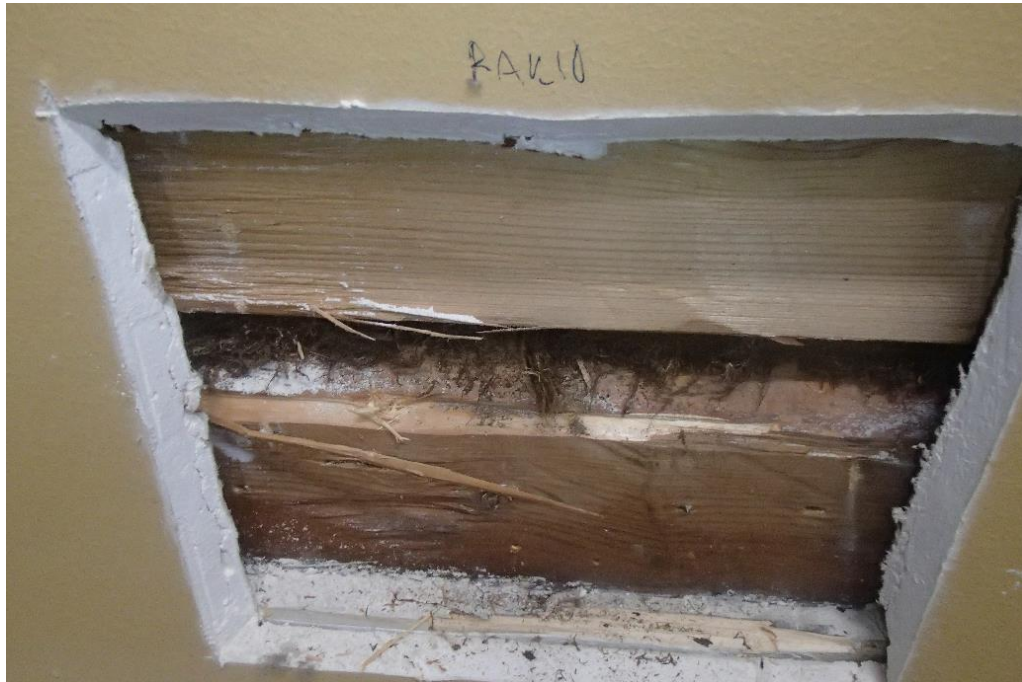
Kuva 62. Rakenneavaus RAK10 luokkahuoneen väliseinään.
