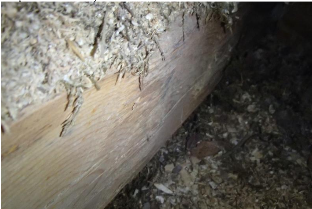
Kuva 38. Välipohjan rakenneavauspaikoissa ei havaittu kantavissa puurakenteissa normaalia poikkeavia havaintoja.
