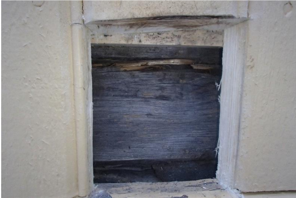
Kuva 63. Rakenneavaus RAKU1 opettajien huoneen ulkovaipparakenteeseen.
