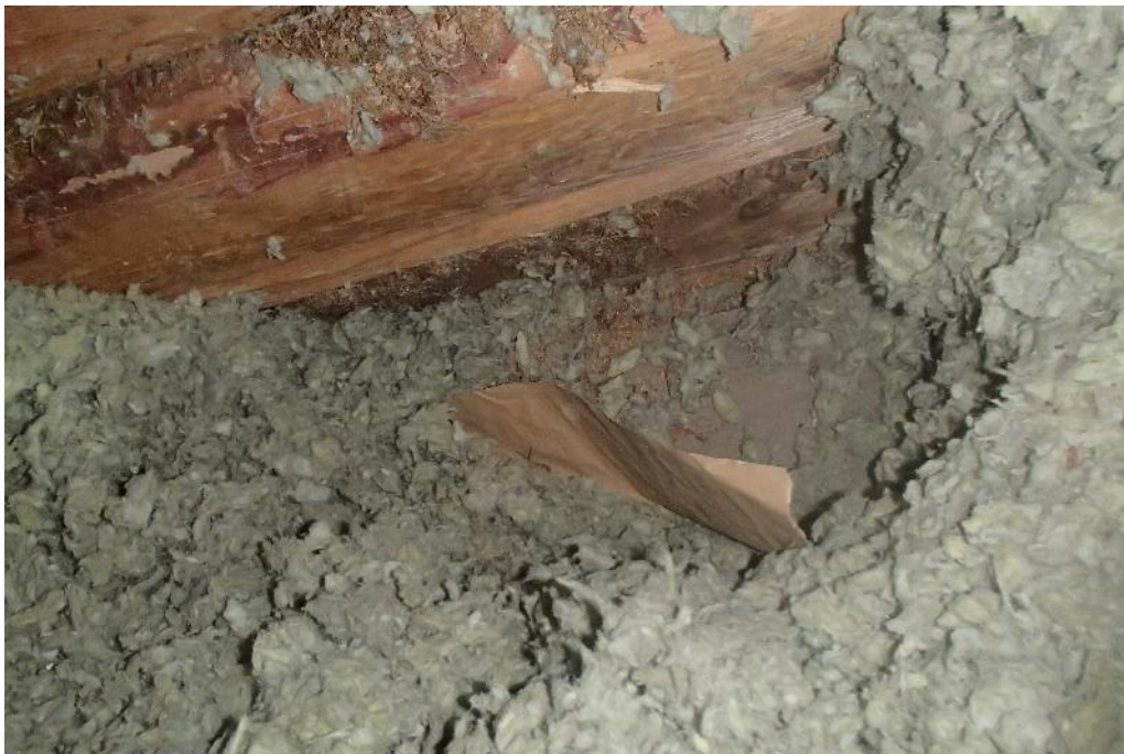
Kuva 44. Rakenneavaus, RAKY1, luokkahuoneen yläpuoleiseen yläpohjaan hirsirungon vierestä.
