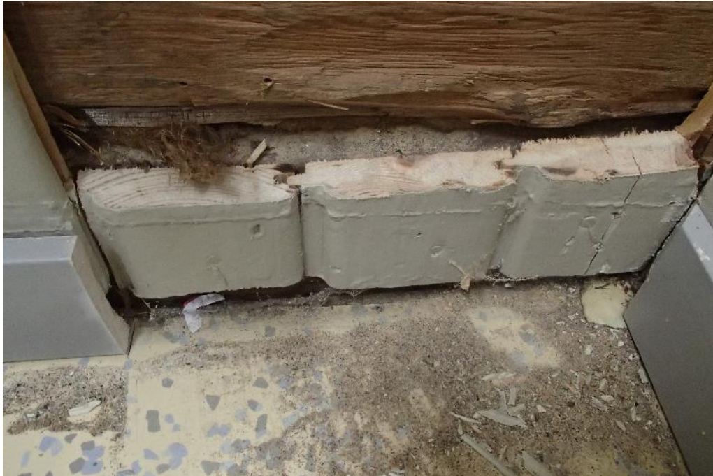
Kuva 60. Rakenneavaus RAK8 musiikkiluokan ulkoseinään.
