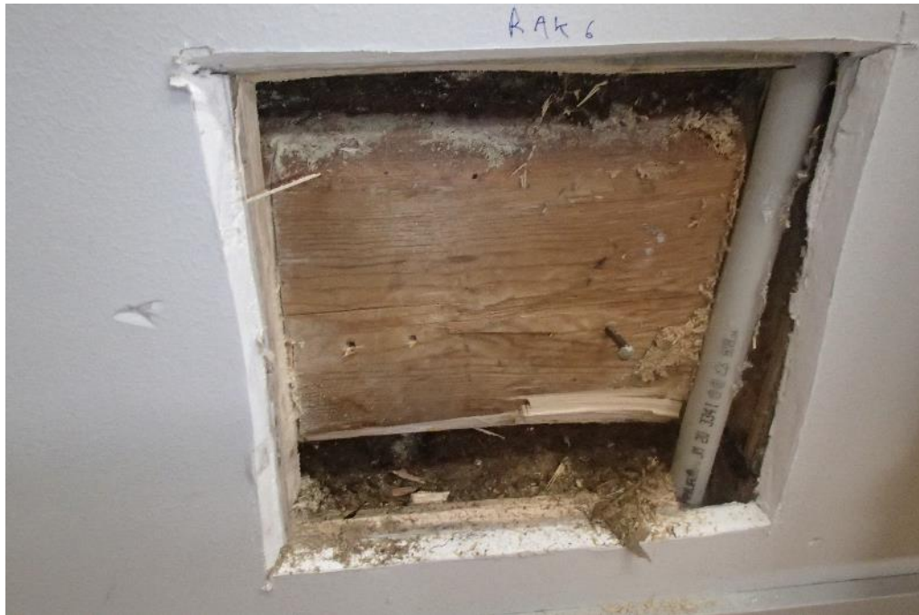
Kuva 58. Rakenneavaus RAK6 puukäsityöluokan ulkoseinään.
