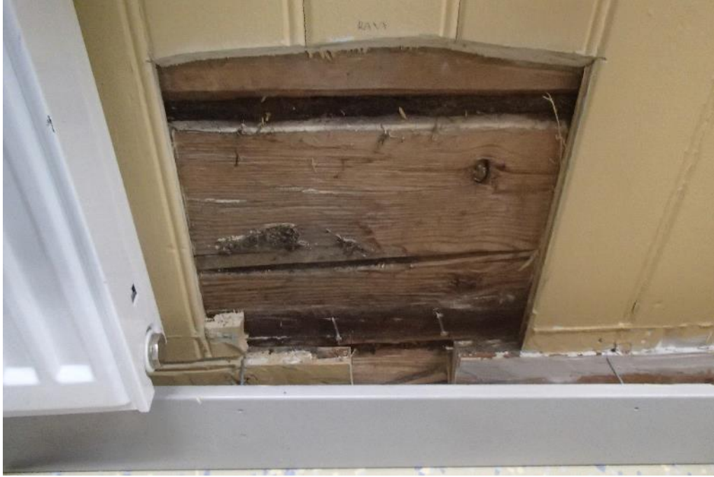
Kuva 59. Rakenneavaus RAK7 luokkahuoneen ulkoseinään.
