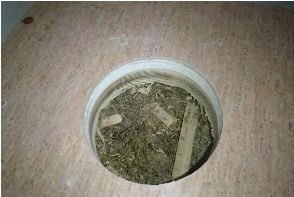
Kuva 31. Rakenneavaus, RAKV1, rehtorin huoneen yläpuoleiseen välipohjaan päätyseinän vierestä.
