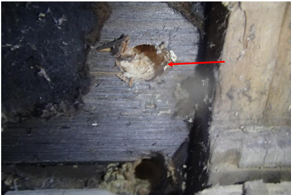
Kuva 70. Hirsirungon ulkopintoihin porattiin reikiä ja porauksen perusteella hirsirungossa ei havaittu lahovaurioita.
