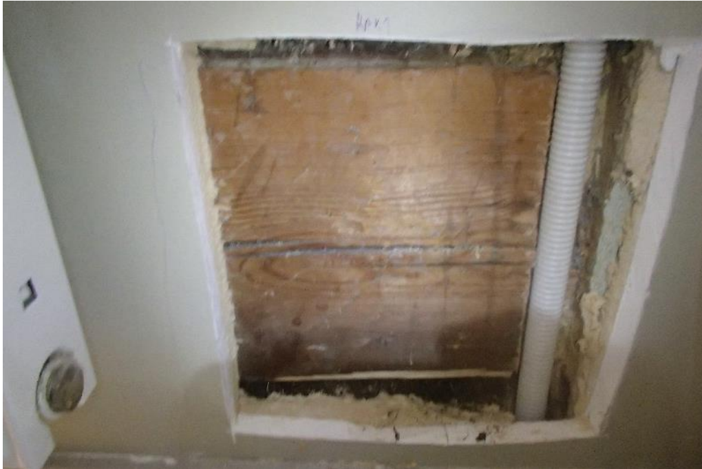
Kuva 53. Rakenneavaus RAK1 rehtorin huoneen ulkoseinään.
