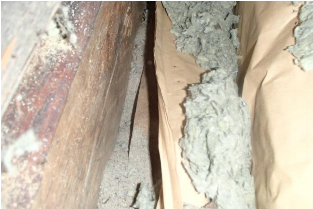
Kuva 46. Rakenneavaus, RAKY2, musiikkiluokan yläpuoleiseen yläpohjaan hirsirungon vierestä.
