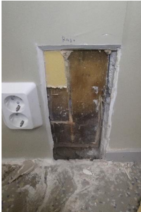
Kuva 61. Rakenneavaus RAK9 terveydenhoitajan huoneen väliseinään.
