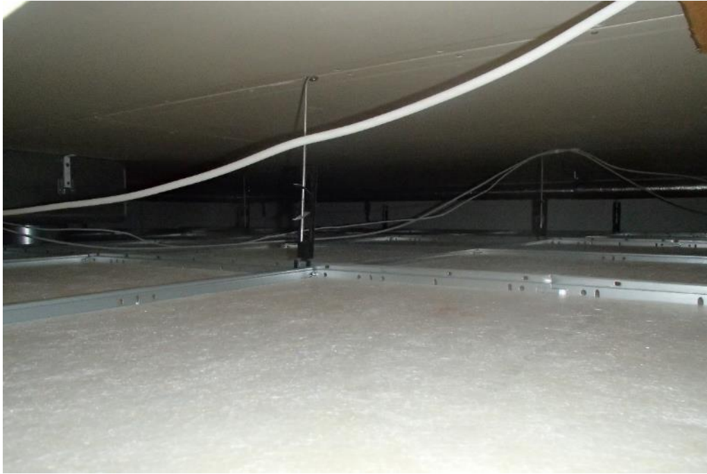
Kuva 41. Alalaskettujen kattojen yläpuolisten rakenteiden vanhoihin pintoihin on asennettu kipsilevyt.
