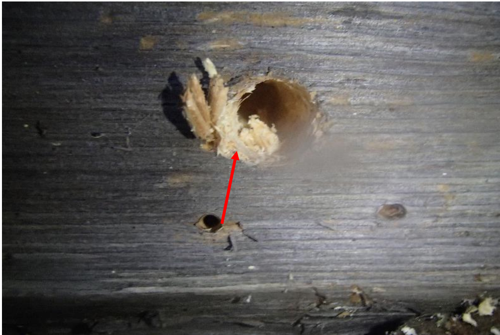
Kuva 69. Hirsirungon ulkopintoihin porattiin reikiä ja porauksen perusteella hirsirungossa ei havaittu lahovaurioita.
