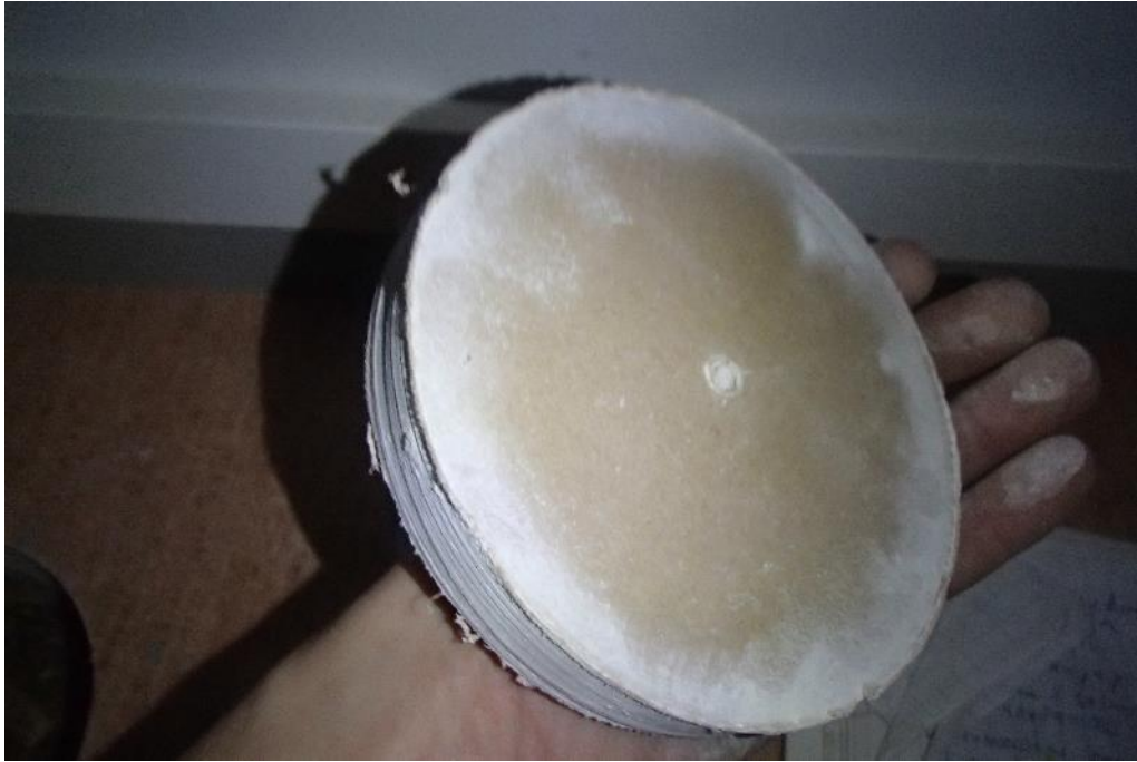
Kuva 35. Välipohjan kipsilevyissä ei havaittu vaurioita.
