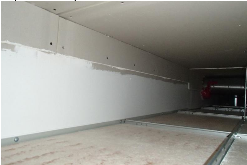
Kuva 40. Alalaskettujen kattojen yläpuolisten rakenteiden vanhoihin pintoihin on asennettu kipsilevyt.
