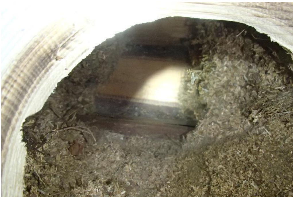
Kuva 32. Rakenneavaus, RAKV1, rehtorin huoneen yläpuoleiseen välipohjaan päätyseinän vierestä.
