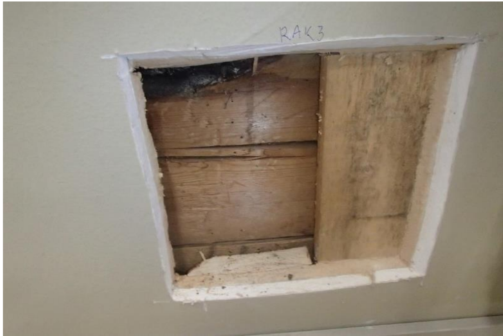
Kuva 55. Rakenneavaus RAK3 opettajien huoneen ulkoseinään.
