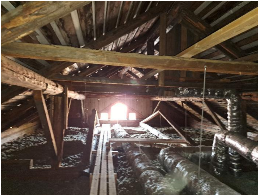
Kuva 43. Yleiskuva vinttitilasta musiikkiluokan yläpuolelta.
