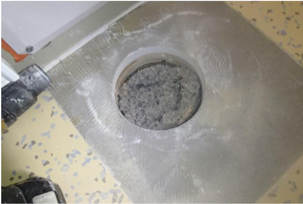
Kuva 1. Rakenneavaus, RAKA1, opettajien huoneen alapohjaan päätyseinän vierestä.
