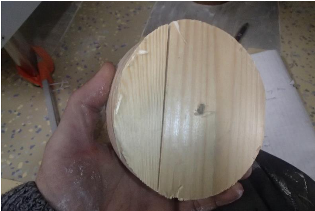
Kuva 7. Lattialankkujen alapinnoilla ei havaittu vaurioita.
