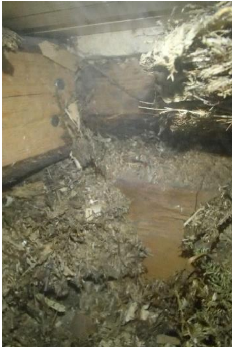
Kuva 39. Välipohjan rakenneavauspaikoissa ei havaittu kantavissa puurakenteissa normaalia poikkeavia havaintoja.
