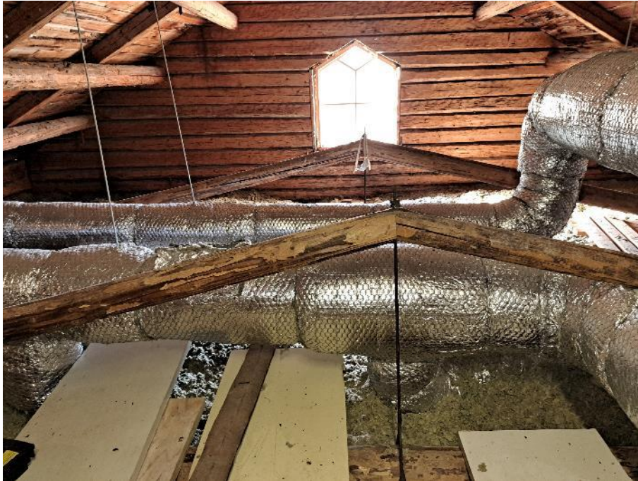
Kuva 42. Yleiskuva vinttitilasta luokkahuoneen yläpuolelta.
