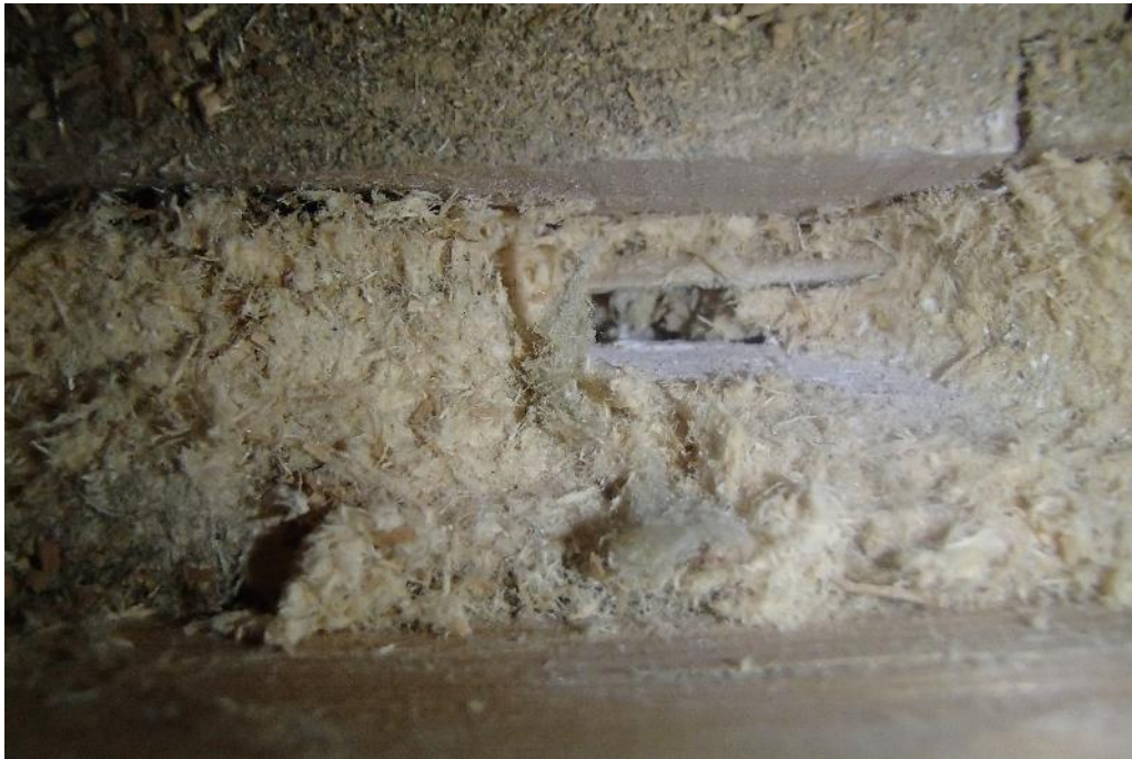
Kuva 45. Rakenneavaus, RAKY1, luokkahuoneen yläpuoleiseen yläpohjaan hirsirungon vierestä.
