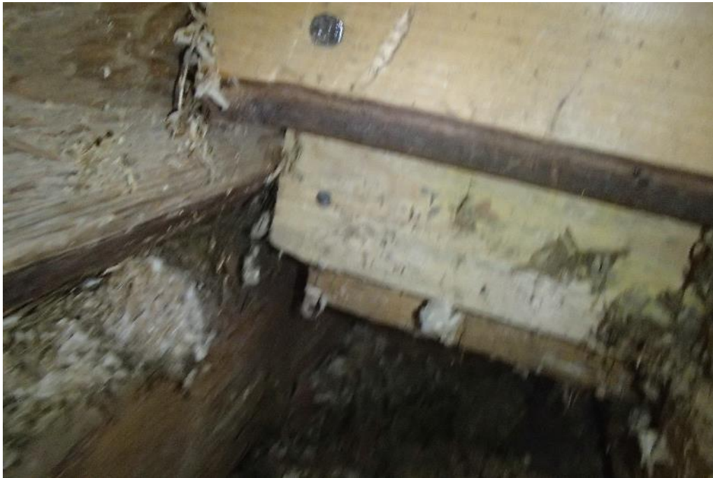
Kuva 37. Välipohjan rakenneavauspaikoissa ei havaittu kantavissa puurakenteissa normaalia poikkeavia havaintoja.
