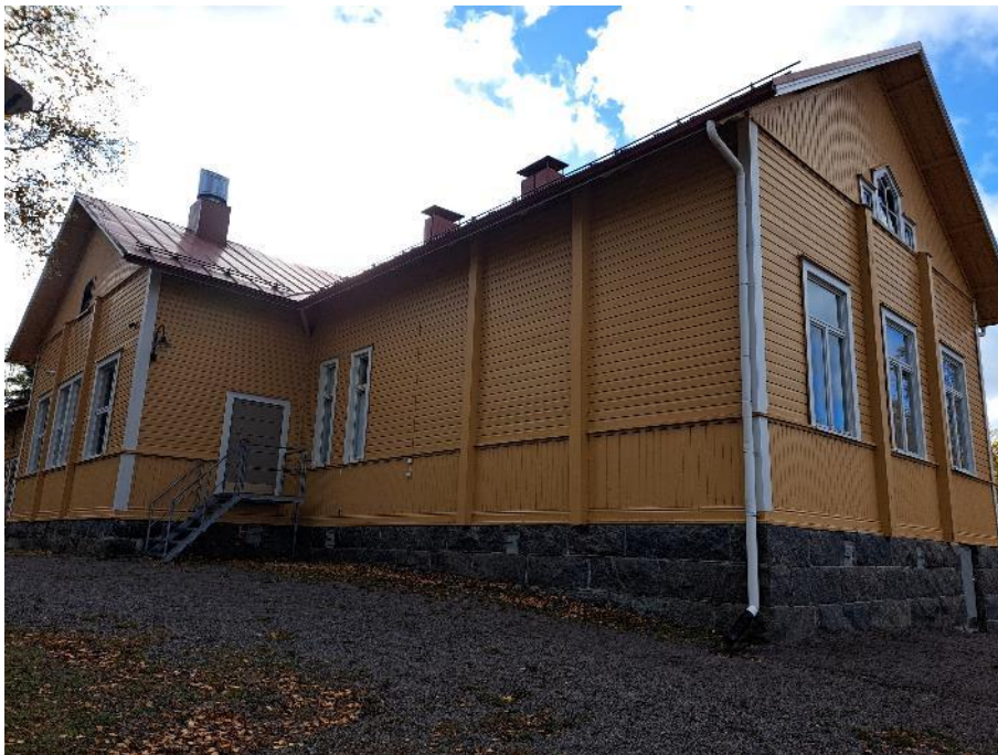
Kuva 66. Ulkoverhouksen maalipinnat ovat pääosin hyvässä kunnossa.
