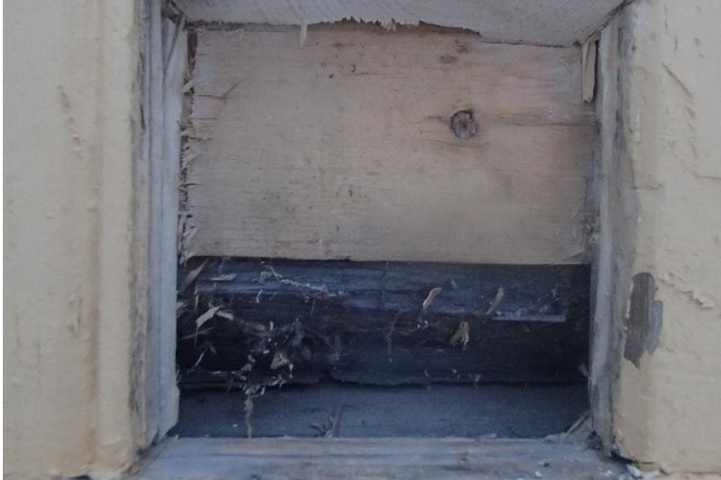
Kuva 65. Rakenneavaus RAKU3 rehtorin huoneen ulkovaipparakenteeseen.
