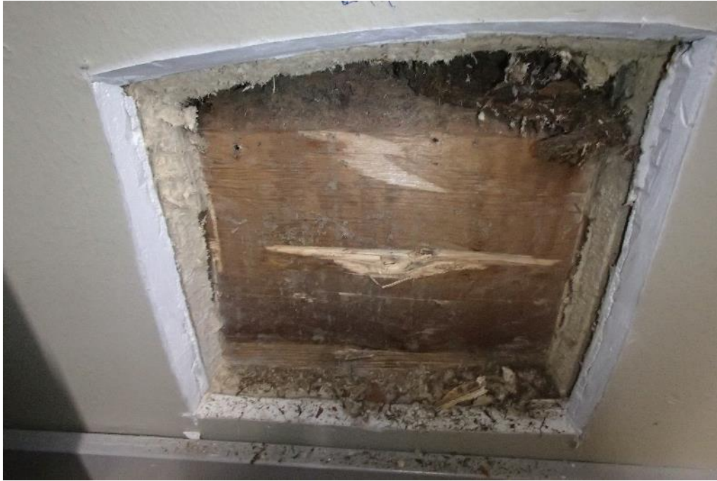
Kuva 56. Rakenneavaus RAK4 rehtorin huoneen ulkoseinään rakennuksen päädystä.
