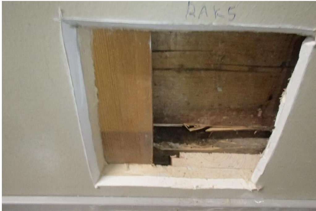
Kuva 57. Rakenneavaus RAK5 terveydenhoitajan huoneen ulkoseinään.
