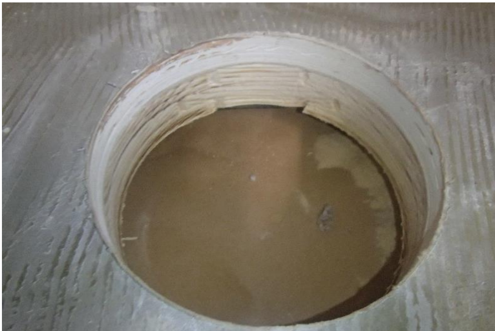
Kuva 3. Rakenneavaus, RAKA2, rehtorin huoneen alapohjaan terveydenhoitajan huoneen välisen väliseinän viereen.
