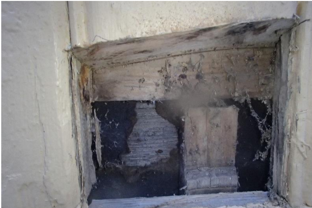
Kuva 64. Rakenneavaus RAKU2 rehtorin huoneen ulkovaipparakenteeseen.
