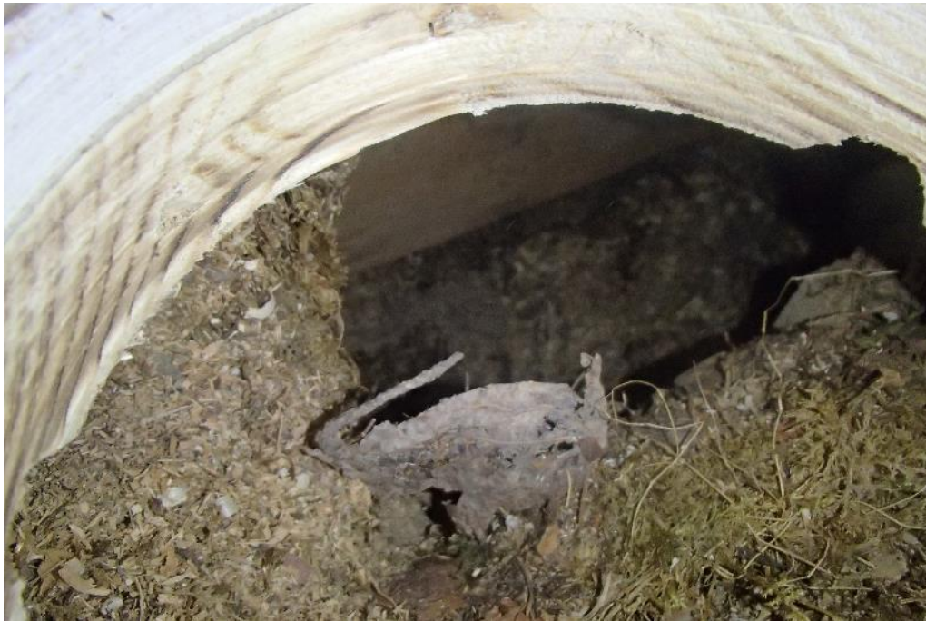
Kuva 34. Rakenneavaus, RAKV2, opettajien huoneen yläpuoleiseen välipohjaan päätyseinän vierestä.
