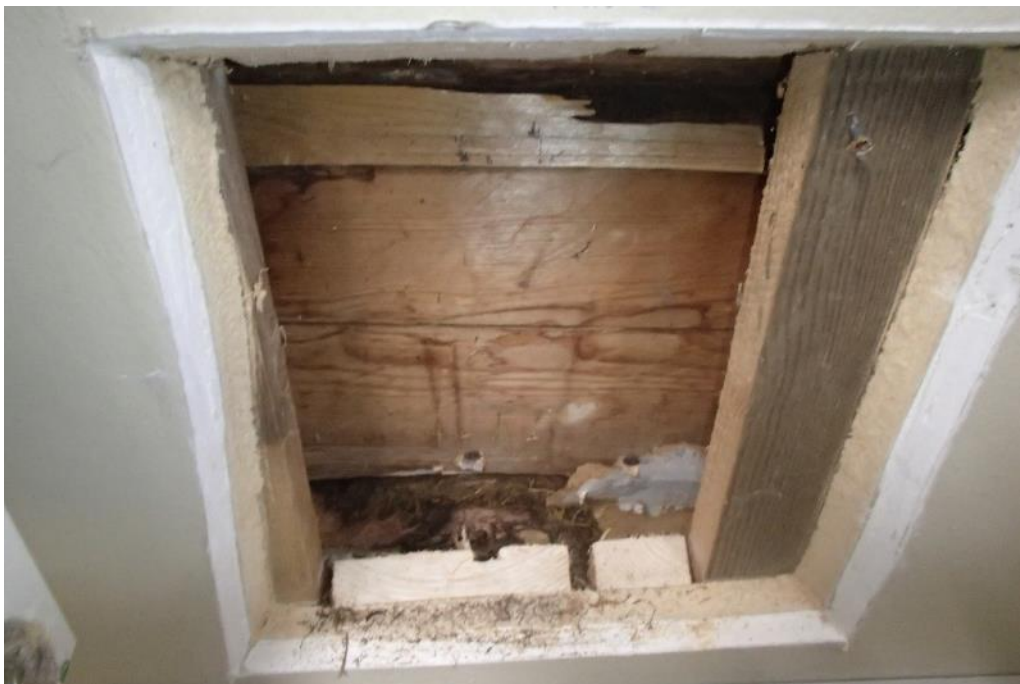
Kuva 54. Rakenneavaus RAK2 opettajien huoneen ulkoseinään.
