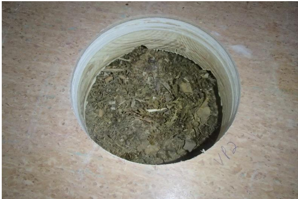
Kuva 33. Rakenneavaus, RAKV2, opettajien huoneen yläpuoleiseen välipohjaan päätyseinän vierestä.
