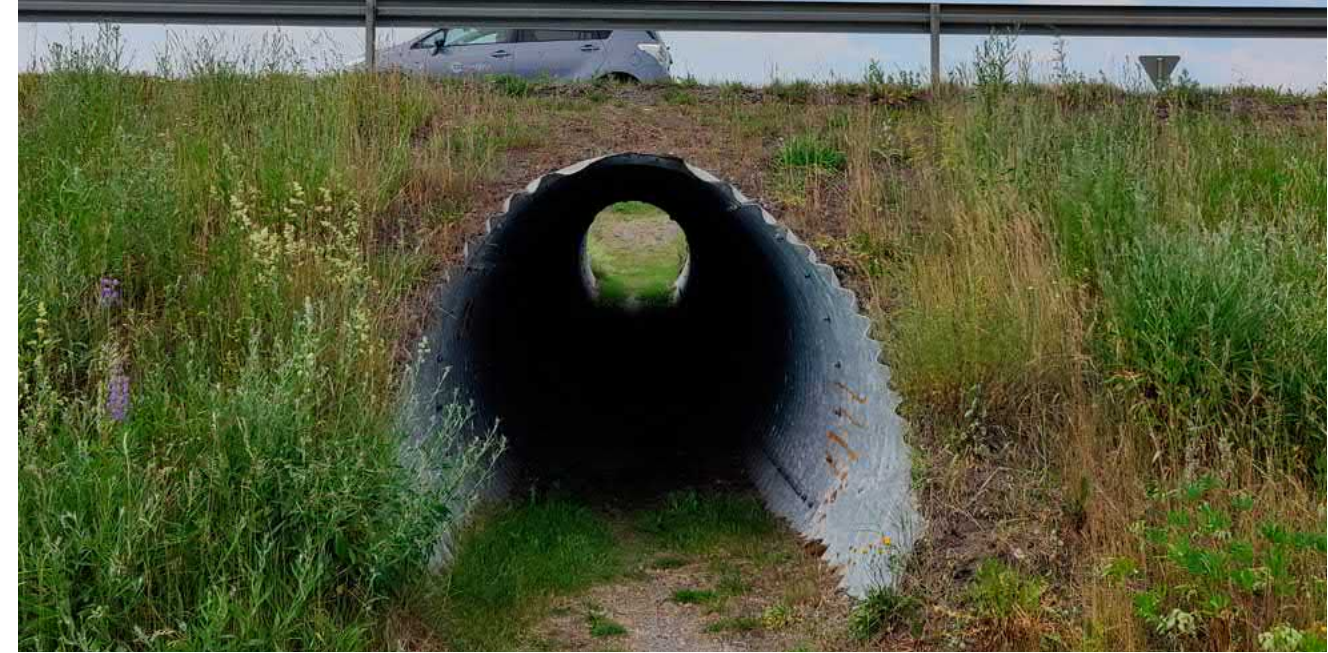
Kuva 20. Teräsputkisilta Vatajantien-Siltaniityntien liittymässä Porvoossa. (Sweco 2022)
