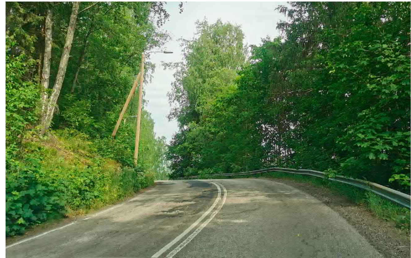
Kuva 28. Heikko näkemä Saksalantiellä Porvoossa. (Sweco 2022)
